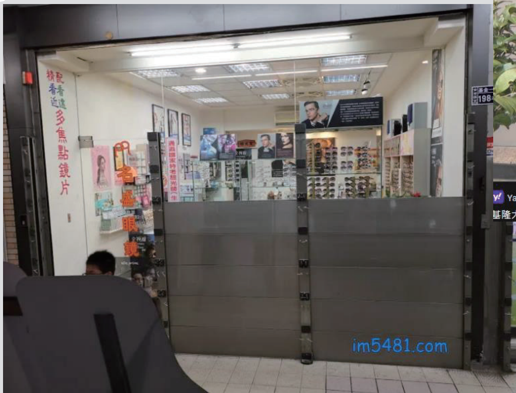
大武崙基金一路的一樓門市擋水門-其在下大豪雨時就會出現
