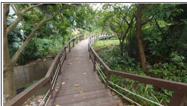
濕地園區對外連絡處入口木棧道已更新。
