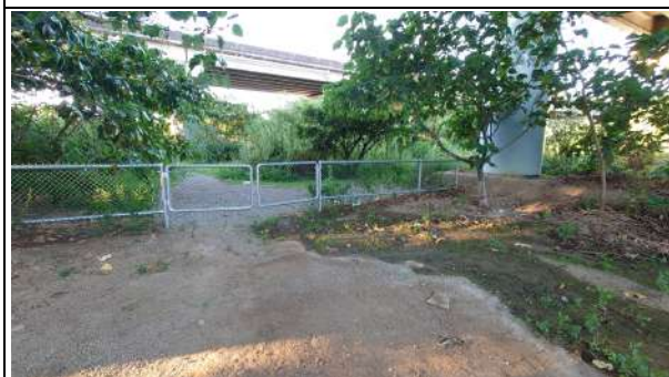
高架橋後方區域為保留區，有柵欄阻絕通行。
