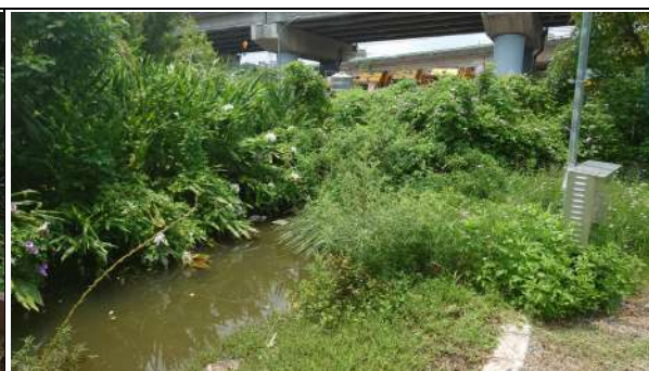
園區入口水生植物生態池完成狀。
