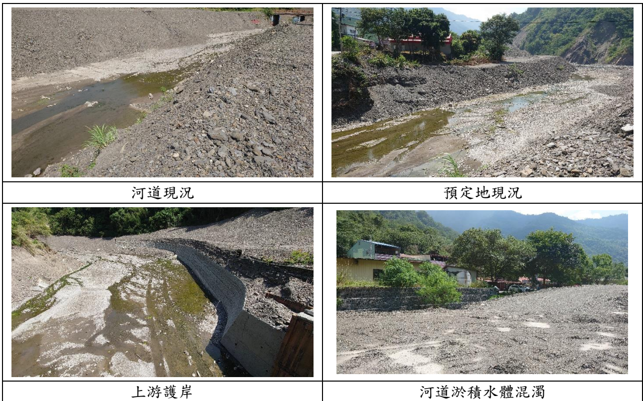
圖 2-1 荖濃溪東庄護岸段改善工程環境現況照
