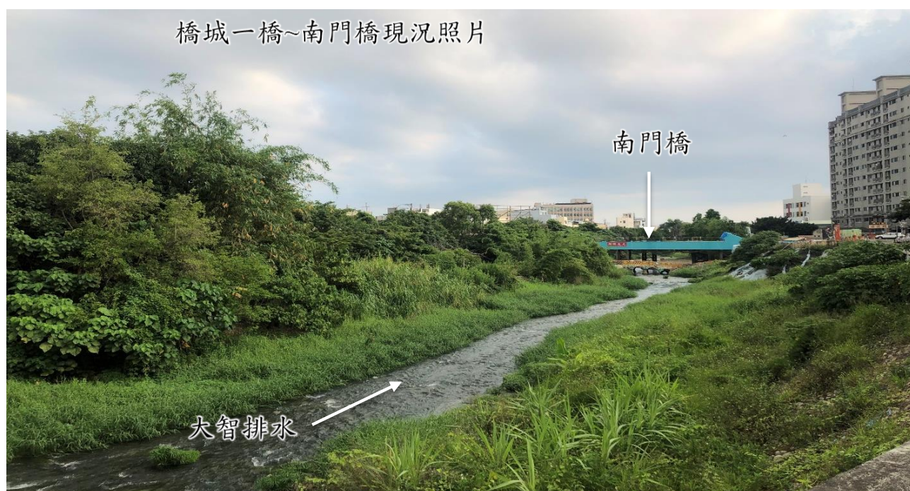
附圖 11 喬城一橋~南門橋現況照片
