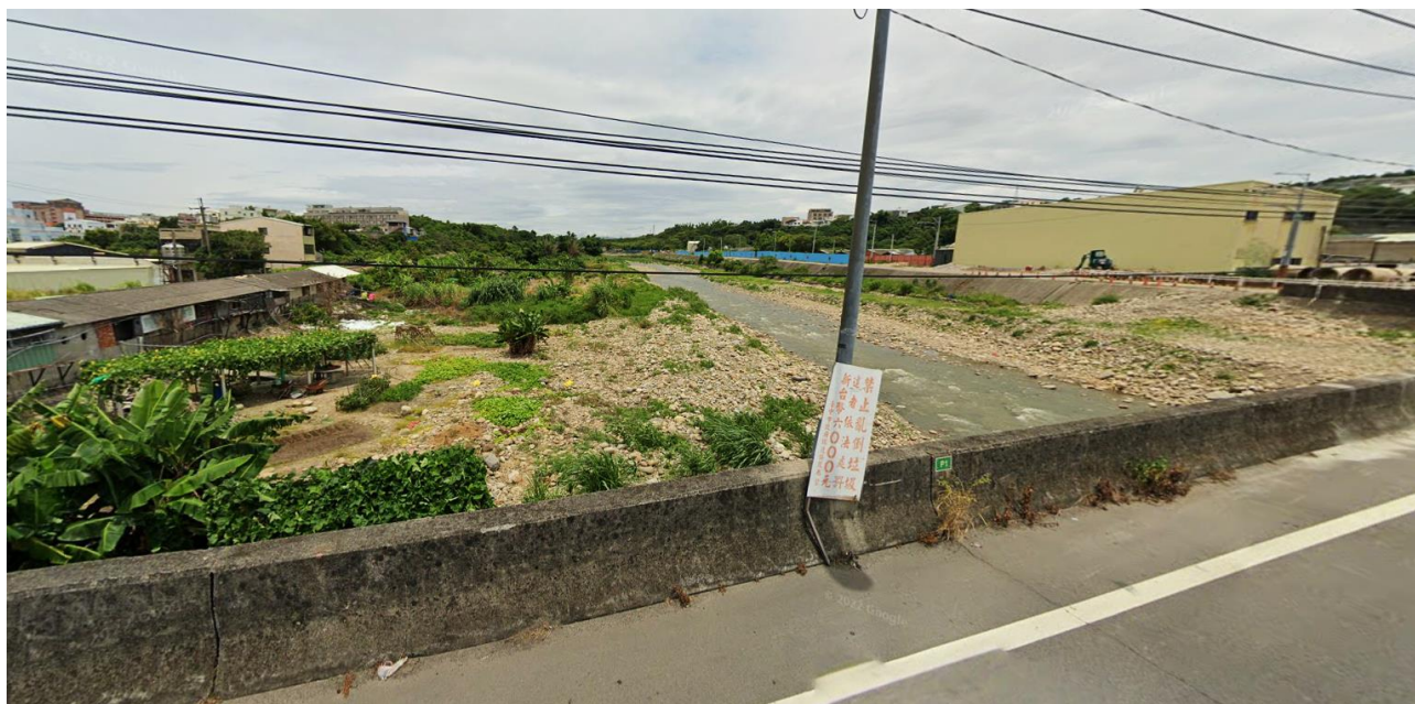
附圖 91 溫寮溪上游(攔河堰-水美街)-現況照片
