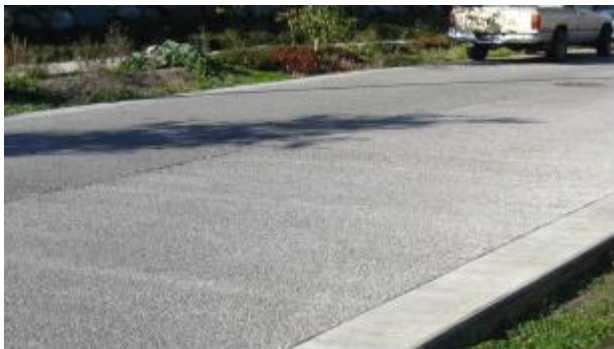
附圖 44 透水混凝土示意圖
