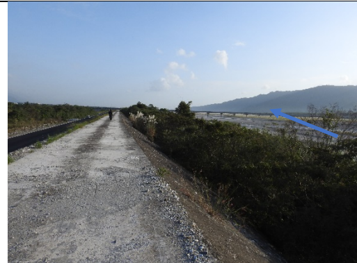
工區區段-水流左岸之堤防。(2019.11.14)(橋為月眉大橋)
