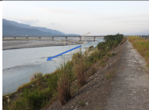
工區段-水流左岸之堤防。(2019.11.14)(橋為月眉大橋)
