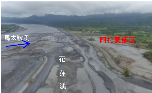
② 土砂暫置區現況
