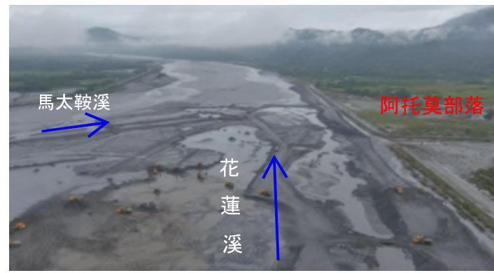
③ 土砂暫置區現況
