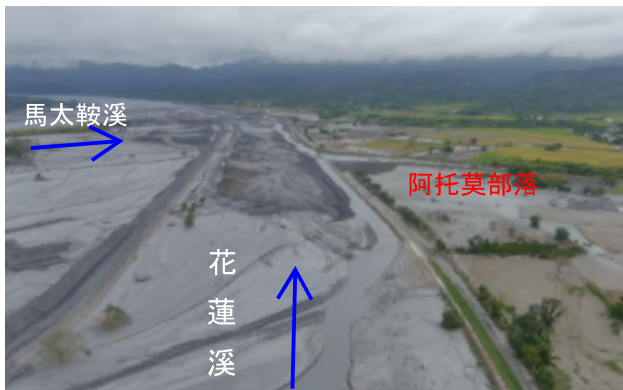
① 土砂暫置區現況
