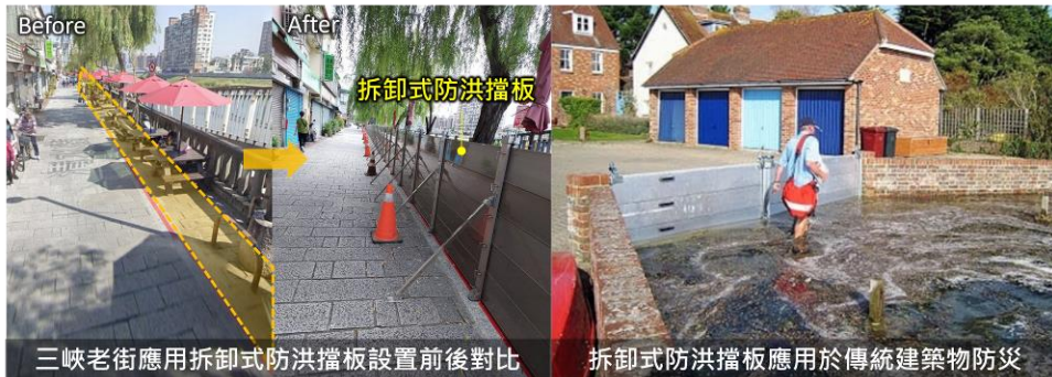
圖 4-5 拆卸式防洪擋板組裝情形
