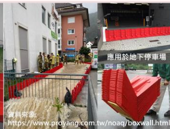
圖 4-6 移動式防洪擋板組裝情形
