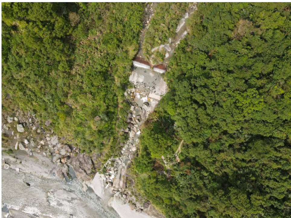
圖 3-29 木瓜溪支流翡翠谷因防砂壩阻斷洄游廊道及棲地縮減
