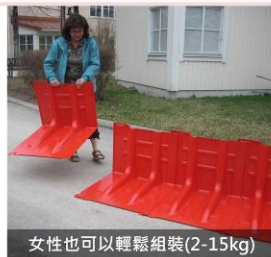
圖 4-6 移動式防洪擋板組裝情形
