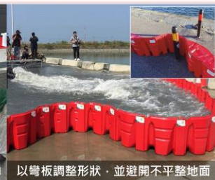
圖 4-6 移動式防洪擋板組裝情形
