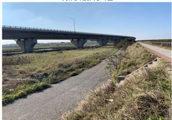
堤內防汛道路
