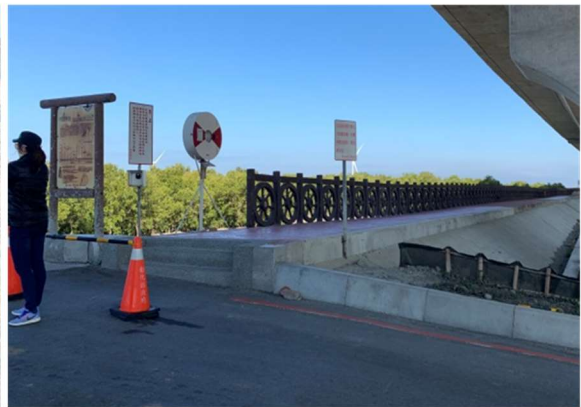
現況堤頂步道
