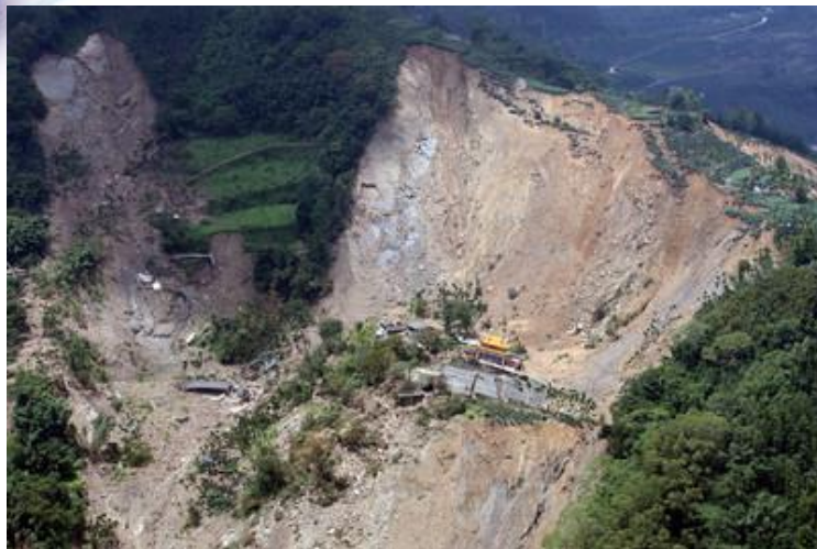
邊坡土石崩塌
