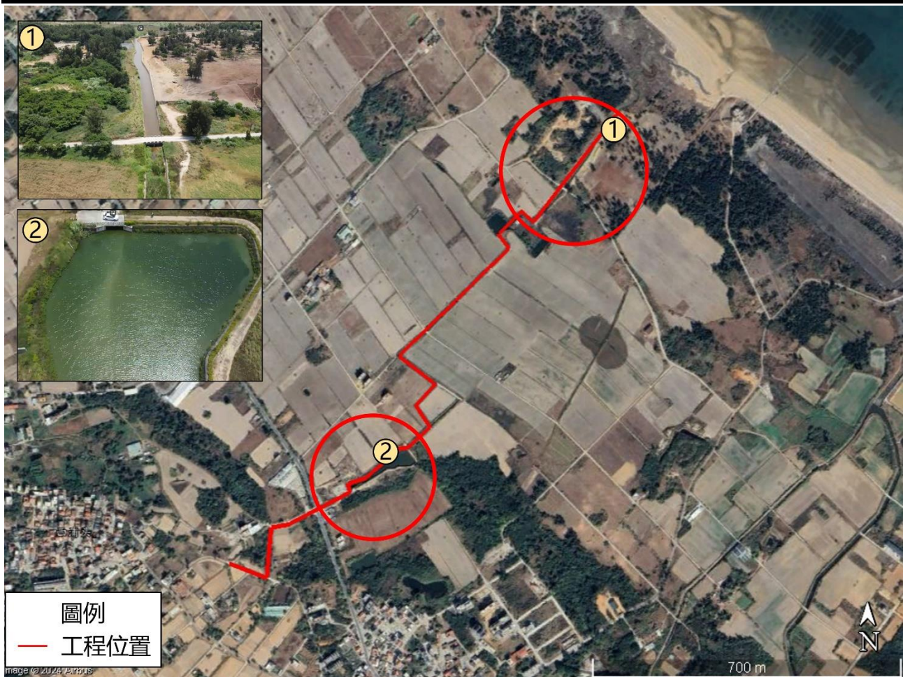
圖 3-116 金寧鄉安岐排水分洪截流工程_施工後衛星雲圖-2024 年
