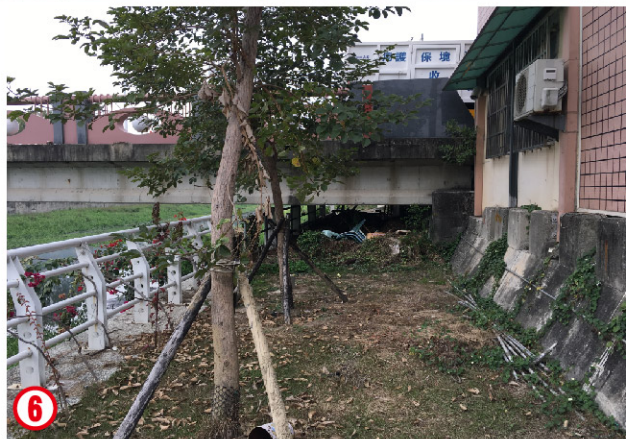
仁壽橋-河華橋右岸尚未建置堤岸步道，且動線受橋樑阻隔。
