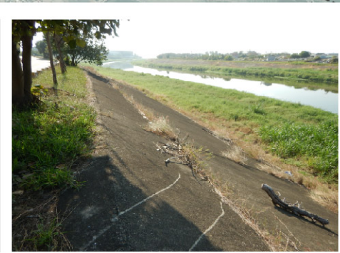
斷面K-左岸 (6k+665~7k+069) 堤頂類型:有堤頂道路 堤前坡:坡面工 堤後坡:工廠、農田
