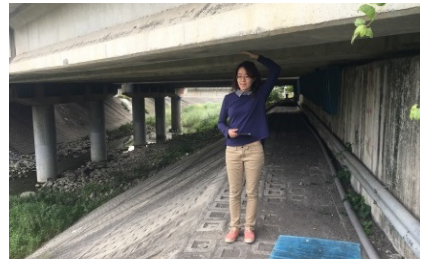
圖伍-26 現況高速公路下方現況影像
