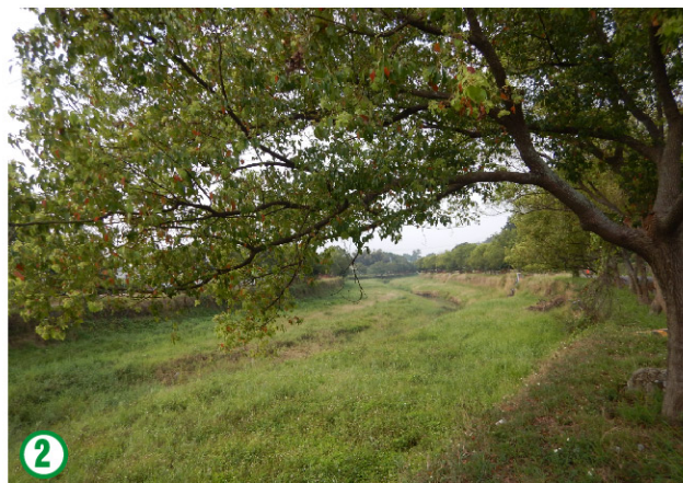
阿公店溪上游河段景觀自然，現況樟樹生長狀況良好，部分堤前坡設置土石籠綠堤防。
