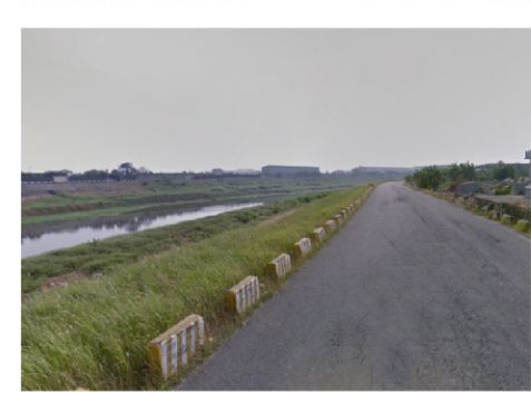
斷面L-右岸 (5k+741~6k+665) 堤頂類型:有堤頂道路 堤前坡:坡面工 堤後坡:墓地
