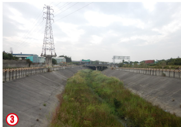
國道陸橋-聖森橋段堤頂及河道皆以混凝土為主，缺乏植栽綠化及遮蔭。
