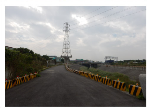
斷面H-左岸 (12k+220~13k+486) 堤頂類型:有堤頂道路 堤前坡:石籠 堤後坡:工廠、農田
