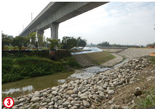
高鐵橋下方部分堤頂動線尚未串聯，堤前坡拋石護岸及堤頂道路建置中。
