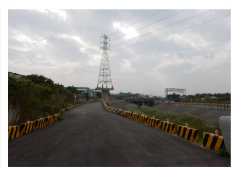
斷面E-左岸 (13k+542~13k+738) 堤頂類型:堤頂道路遇國 道終止 堤前坡:坡面工 堤後坡:工廠
