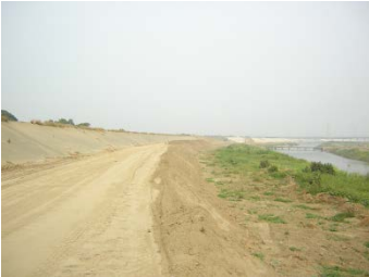
曾文溪改善前堤岸照片
