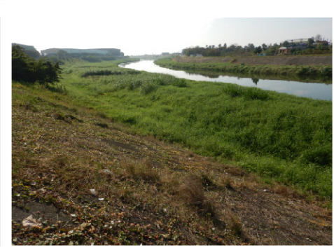
斷面L-左岸 (5k+741~6k+665) 堤頂類型:有堤頂道路 堤前坡:坡面工 堤後坡:農田、工廠
