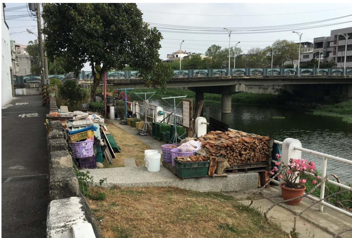
圖陸-50 壽峰橋~河華橋現況影像
