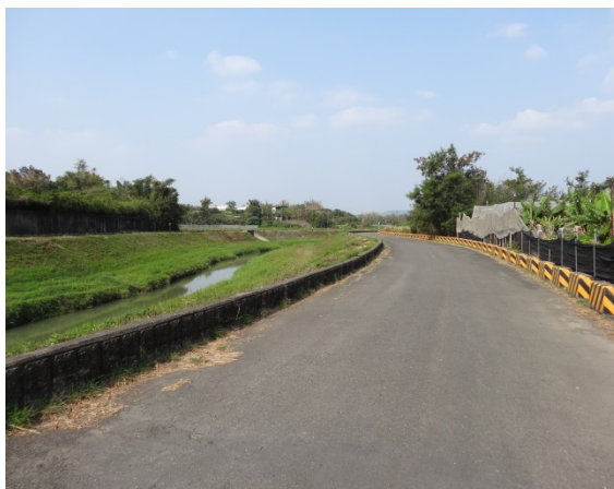
圖陸-71 水庫溢洪道~小崗山橋現況影像
