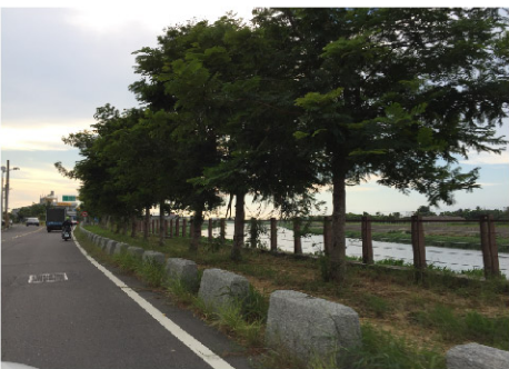
斷面M-左岸 (5k+027~5k+741) 堤頂類型:有堤頂道路 堤前坡:石籠 堤後坡:工廠
