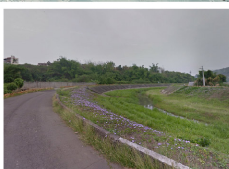
斷面A-左岸 (17k+745~18k+072) 堤頂類型:有堤頂道路 堤前坡:坡面工或石籠 堤後坡:農田
