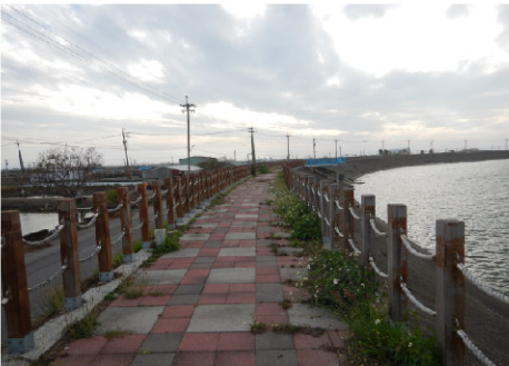
斷面P-左岸 (0k+601~0k+939) 堤頂類型:有堤頂道路 堤前坡:坡面工 堤後坡:綠帶、車道
