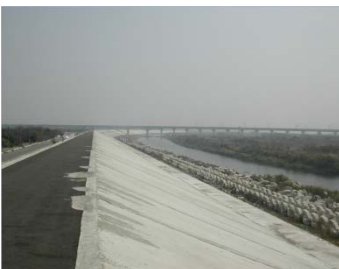
曾文溪改善前堤岸照片
