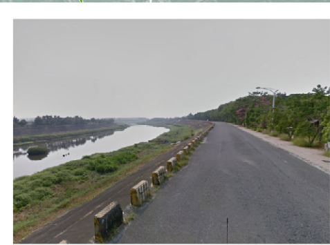
斷面K-右岸 (6k+665~7k+069) 堤頂類型:有堤頂道路 堤前坡:坡面工 堤後坡:本洲濕地
