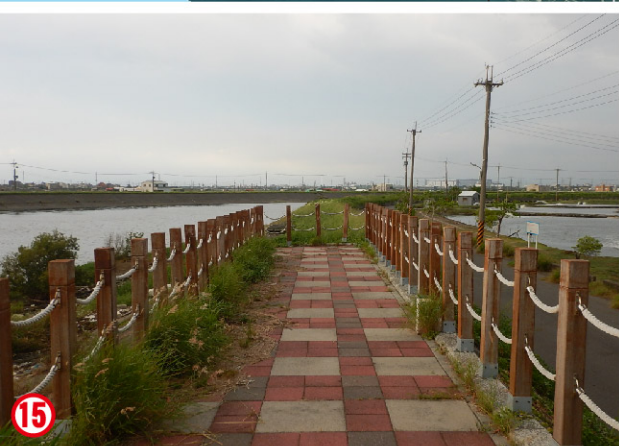
出海口處局部河堤設有步道，但前後端無串連且缺乏植栽遮蔭及綠化。
