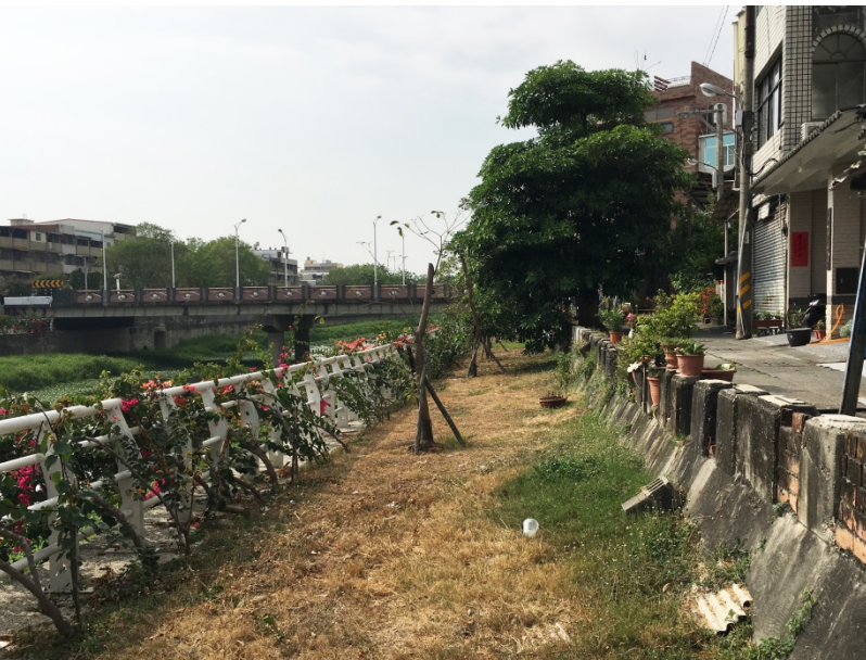
圖陸-47 仁壽橋~中華橋現況影像
