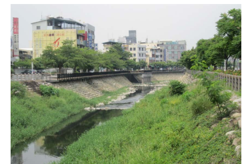
圖伍-23 漿砌塊石工法示意
