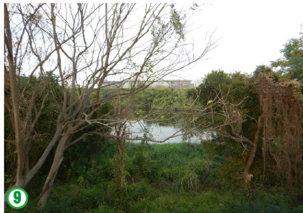
本洲滯洪公園設有池岸棧道、木造遊息平台等，提供里民休閒場地，惟現況因維護不佳，多處硬體設施損壞待修。
