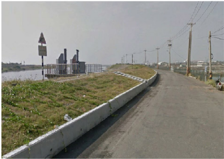
斷面Q-右岸 (0k~0k+601) 堤頂類型:無堤頂道路 堤前坡:坡面工 堤後坡:魚塭
