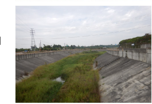
斷面E-左岸 (13k+542~13k+738) 堤頂類型:堤頂道路遇國 道終止 堤前坡:坡面工 堤後坡:工廠
