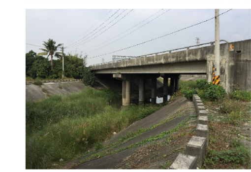
斷面F-左岸 (13k+495~13k+542) 堤頂類型:無堤頂道路 堤前坡:坡面工 堤後坡:無
