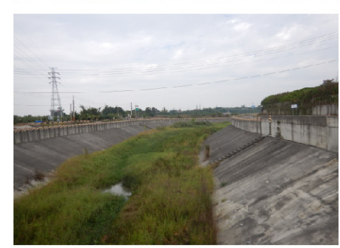
斷面H-右岸 (12k+220~13k+486) 堤頂類型:有堤頂道路 堤前坡:坡面工 堤後坡:工廠、農田
