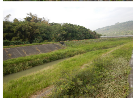
斷面B-右岸 (16k+958~17k+745) 堤頂類型:有堤頂道路 堤前坡:坡面工 堤後坡:農田
