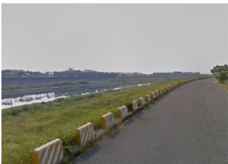
斷面N-右岸 (3k+466~5k+027) 堤頂類型:有堤頂道路 堤前坡:坡面工 堤後坡:魚塭、空地
