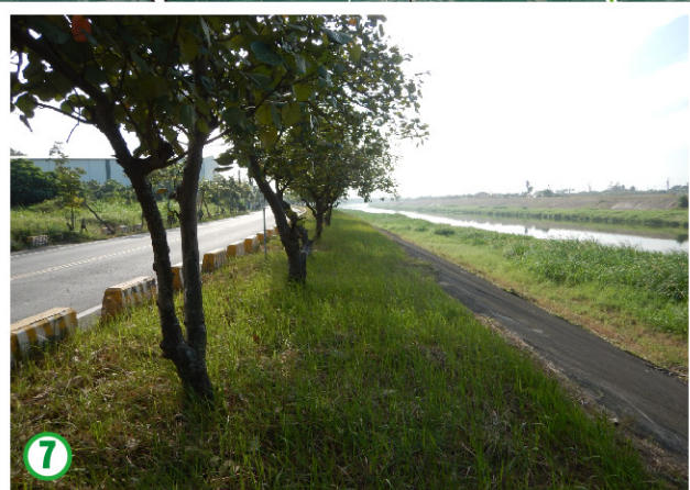
前洲橋-山霸畑路部分堤岸種植黃槿及盾柱木，現況生長狀況良好。
