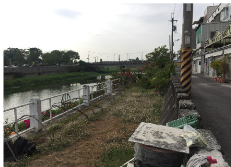
斷面I-右岸 (8k+376~9k+121) 堤頂類型:無堤頂道路 堤前坡:坡面工 堤後坡:建物、校舍
