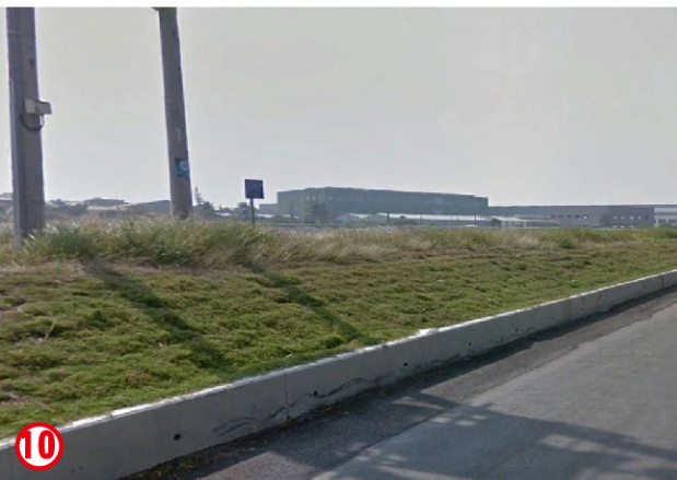
阿公店溪下游堤防高於路面，現況無種植喬木遮蔭且無設置堤頂步道。
