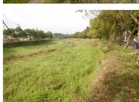
斷面C-右岸 (15k+647~16k+958) 堤頂類型:有堤頂道路 堤前坡:石籠 堤後坡:農田
