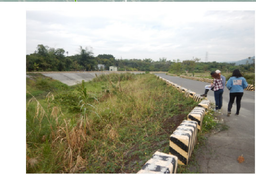
斷面D-左岸 (14k+147~14k+783) 堤頂類型:有堤頂道路 堤前坡:石籠 堤後坡:農田
