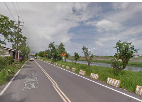
斷面N-左岸 (3k+466~5k+027) 堤頂類型:有堤頂道路 堤前坡:石籠 堤後坡:工廠
