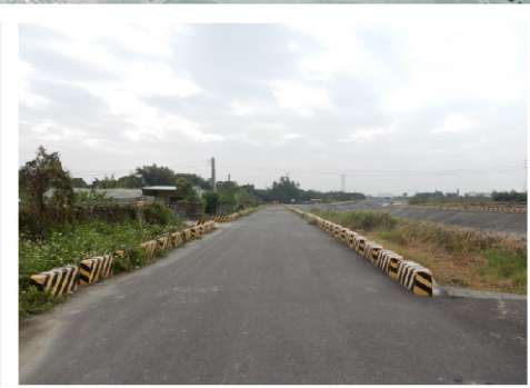
斷面D-左岸 (14k+147~14k+783) 堤頂類型:有堤頂道路 堤前坡:石籠 堤後坡:農田
