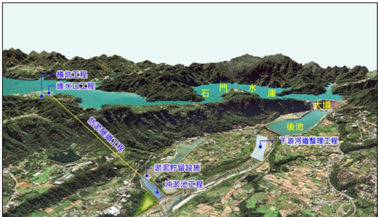
圖1-1 阿姆坪防淤隧道及下游河道整理工程
