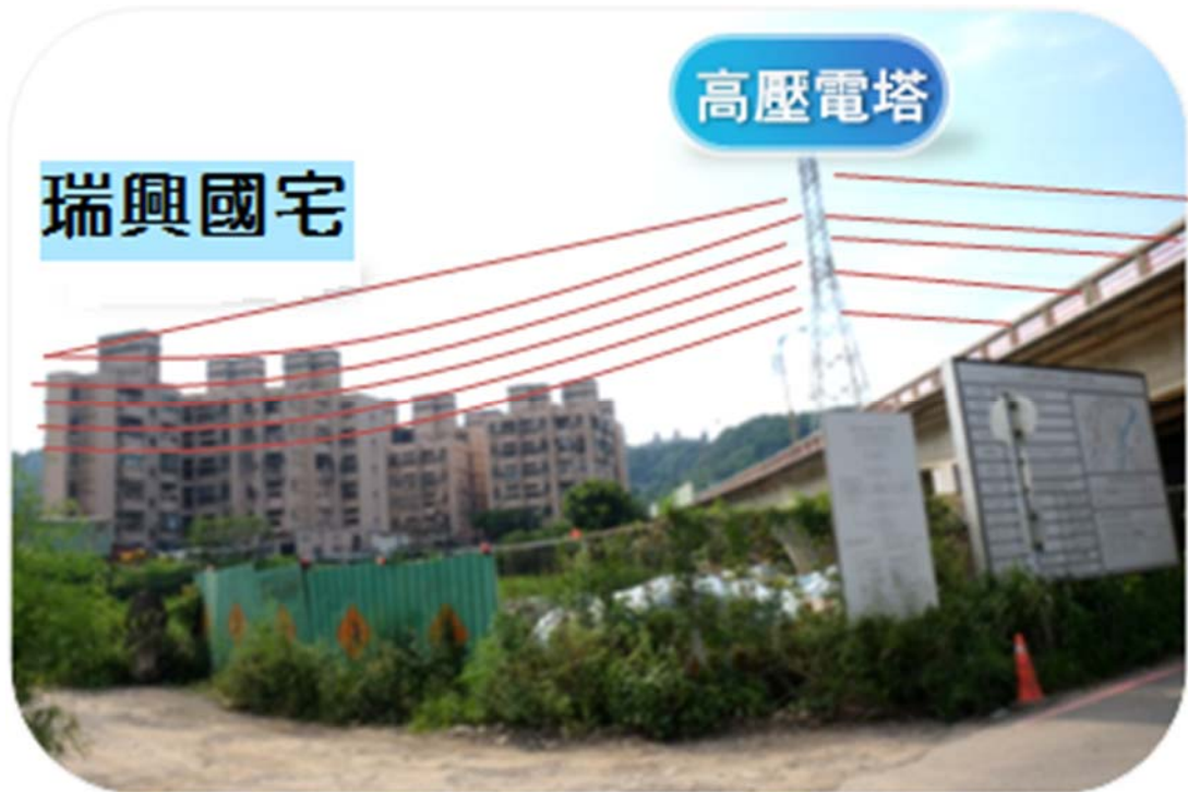
圖5-1 高壓電纜穿越瑞興國宅
