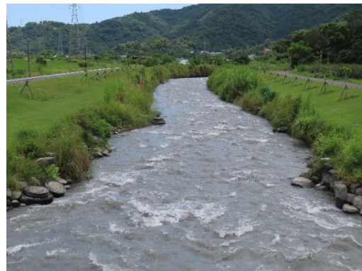
雙賢二號橋下游現況(民國 109 年 8 月)
