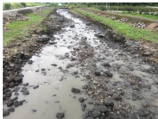
雙賢二號橋下游枯水情況(民國 107 年 7 月)
