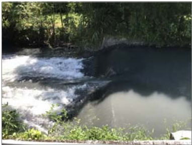
斷面左岸往右岸方向
