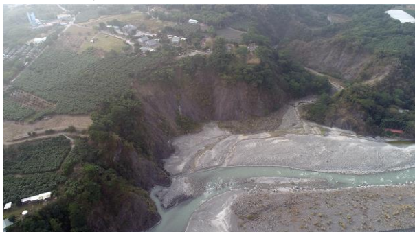
荖濃護岸工程預定地環境現況 108/11/27
