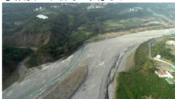
荖濃護岸工程預定地上游現況 108/11/27
