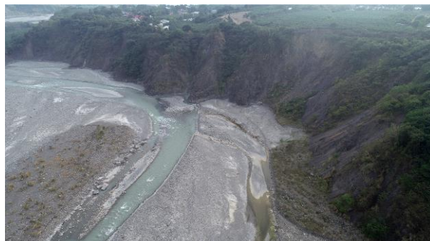
荖濃護岸工程預定地環境現況 108/11/27
