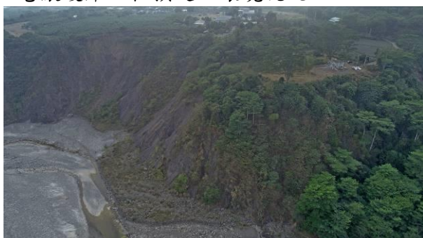
荖濃護岸工程預定地環境現況 108/11/27
