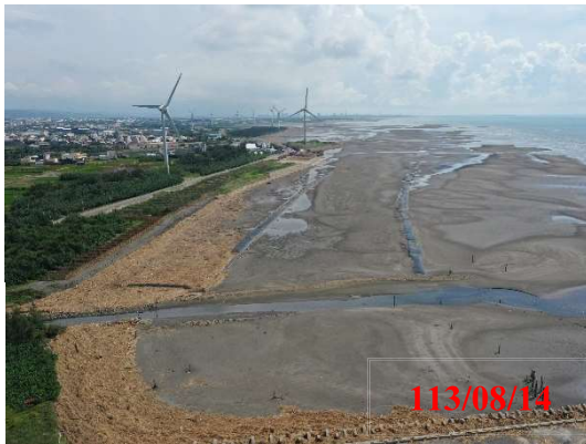
北汕海堤堤前空拍現況
