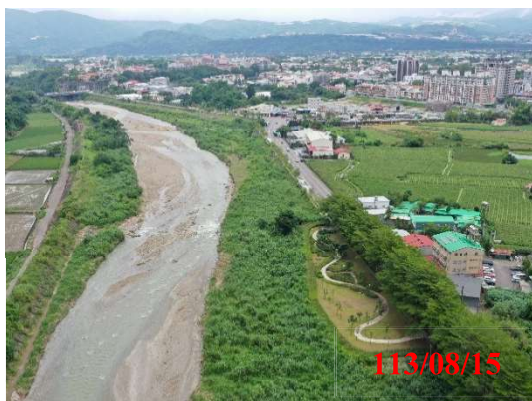
南港溪溪北一號堤段堤前現況
