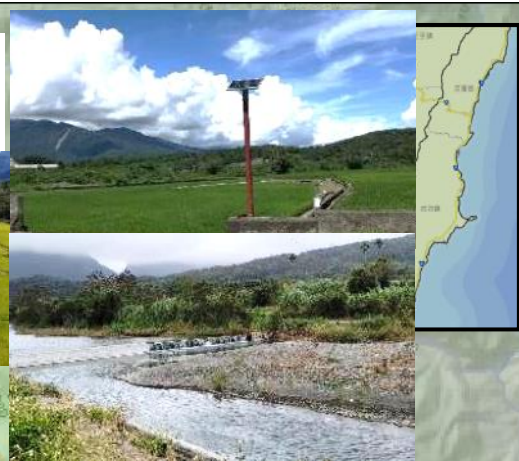
農水署花蓮管理處： 110年水圳測水流量 攔河堰評估調整為曲線斜堰
