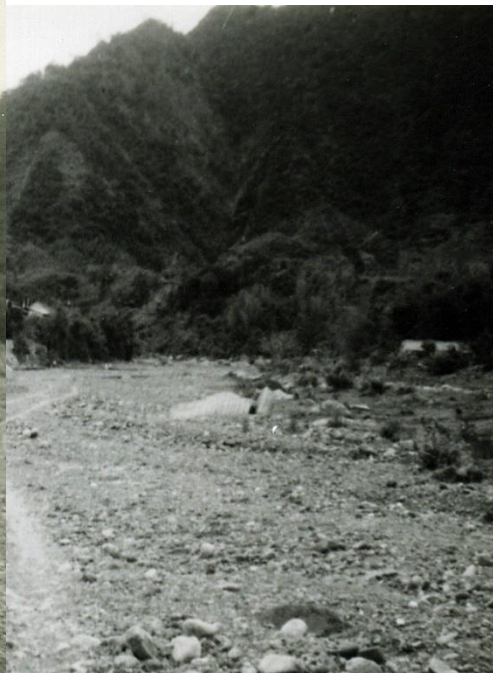
1960年池豐橋上游 河道內像施工。
