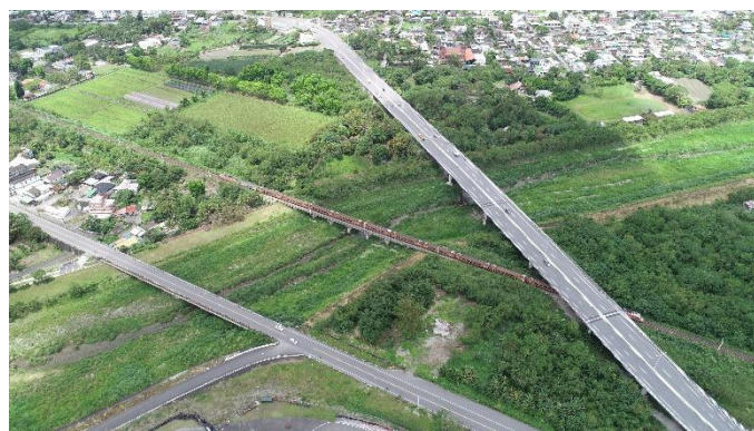
圖二、工區範圍由左岸往右岸拍攝，和榮橋的左右岸堤後有次生林環境，堤外無大型喬木。(拍攝日期:110年6月)
