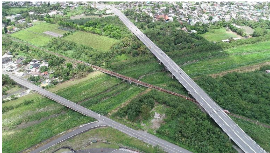
圖 8、由左岸往右岸拍攝，和榮橋的左右岸堤後有次生林環境，堤外無大型喬木。(拍攝日期:110 年 6 月)
