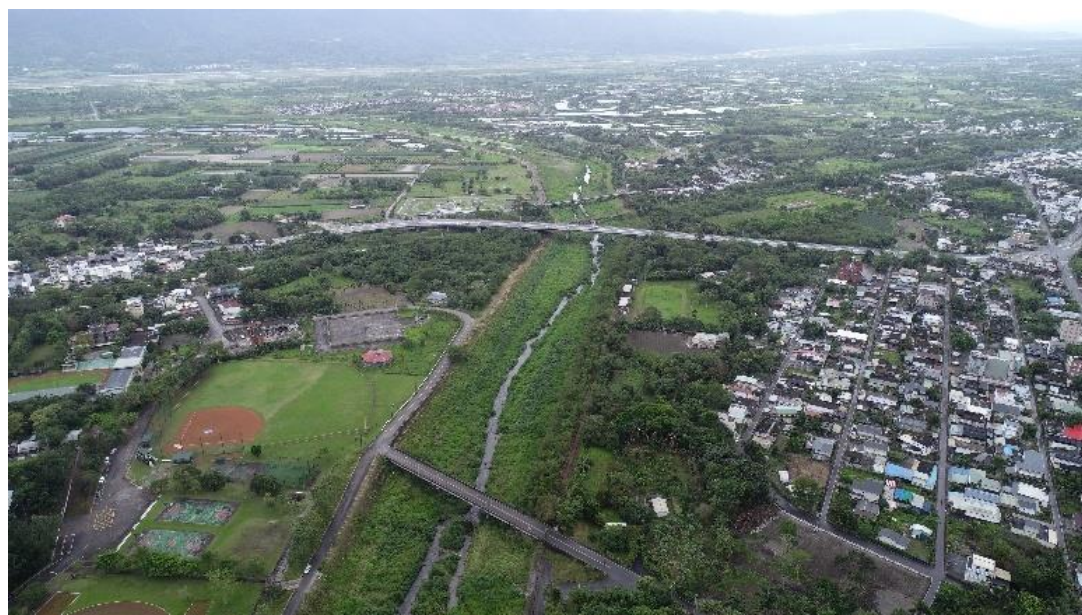
圖 7、由上游往下游拍攝，堤後左右岸皆有次生林及農墾地，堤外無大型喬木。(拍攝日期:110 年 6 月)
