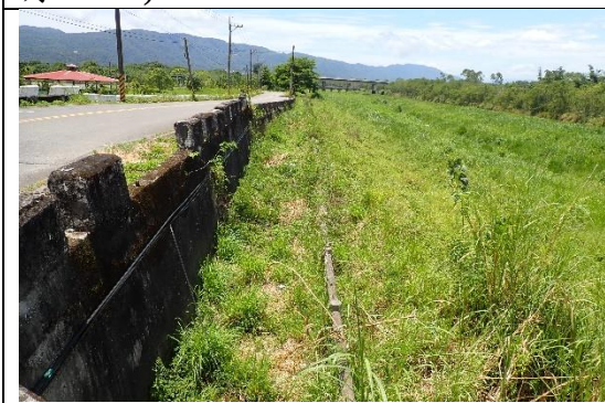
圖 3、左岸鄰近道路堤防多為高草生地。(拍攝日期:110 年 5 月 20 日)
