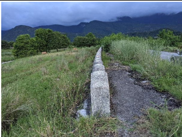
圖七、下荖溪橋往下游800公尺左岸堤防末段，堤外有高大喬木。(拍攝日期:110年8月)
