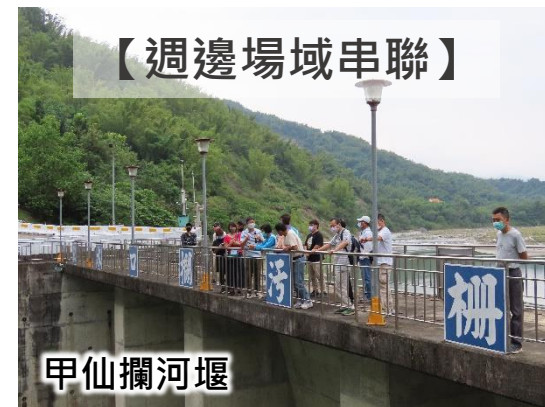
甲仙攔河堰管理中心
