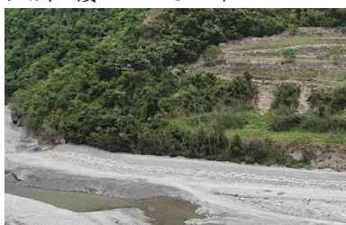
照片-棲地 1-施工中
