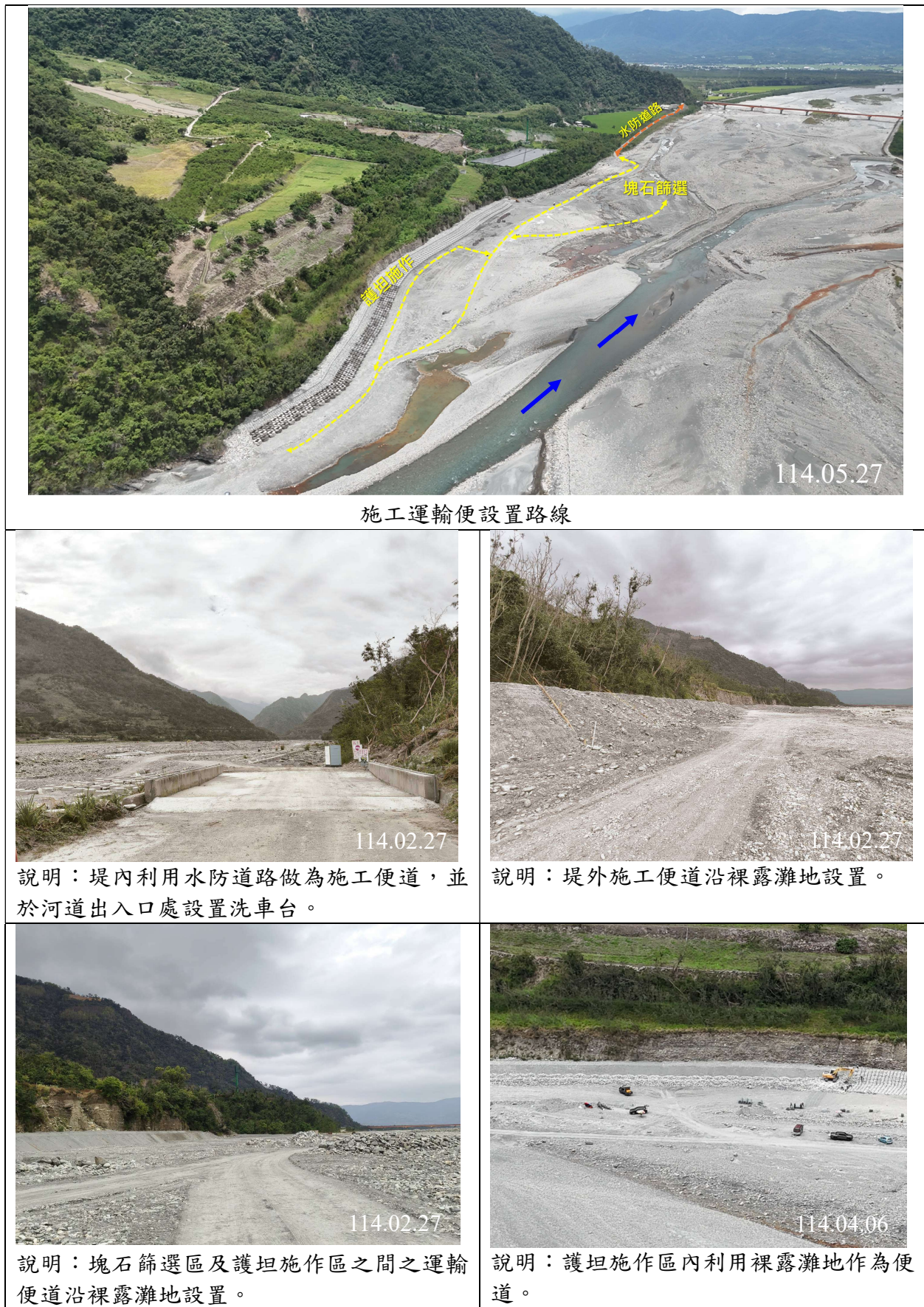
圖2-16 施工便道設置情形
