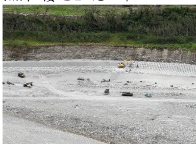
照片-棲地 2-施工中
