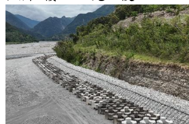
照片-棲地 1-完工後
