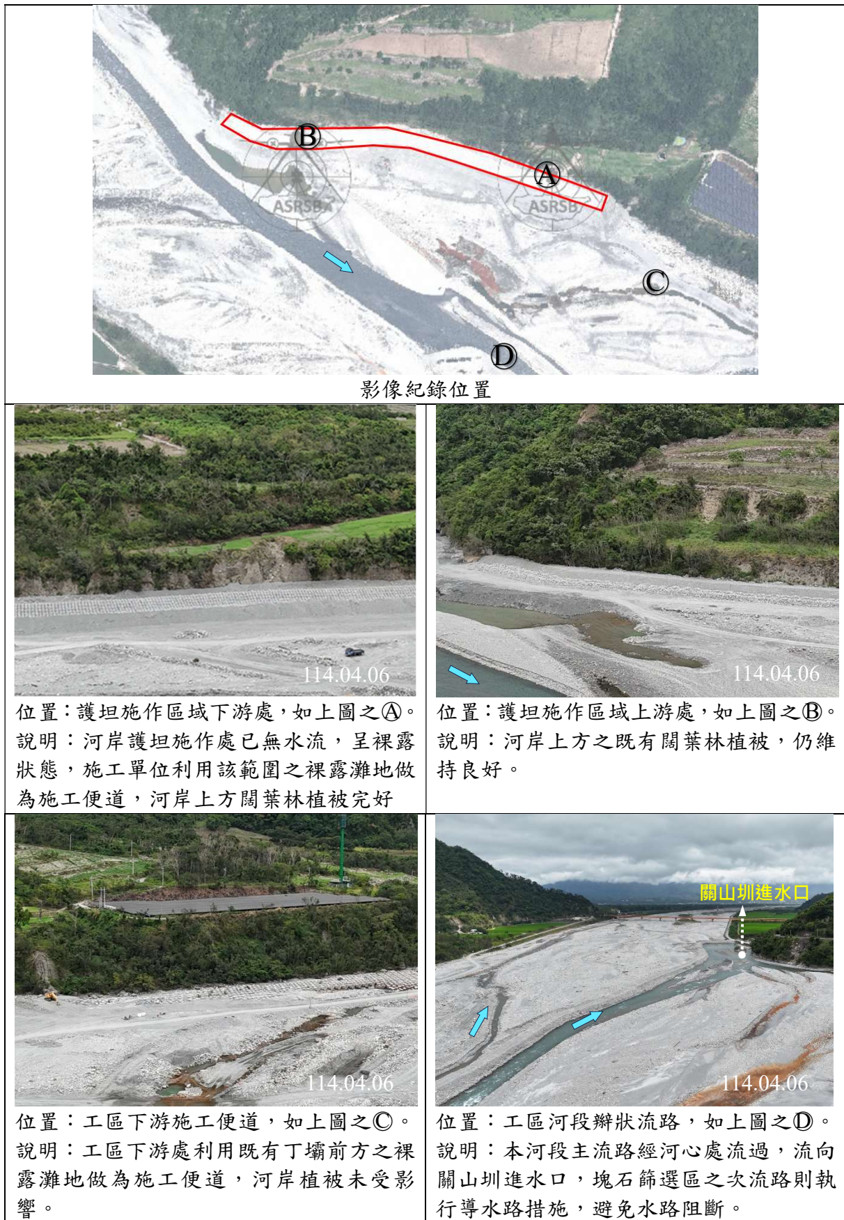
圖 2-6 施工中環境概況紀錄(2)
