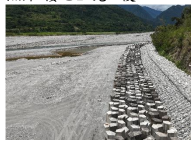
照片-棲地 2-完工後
