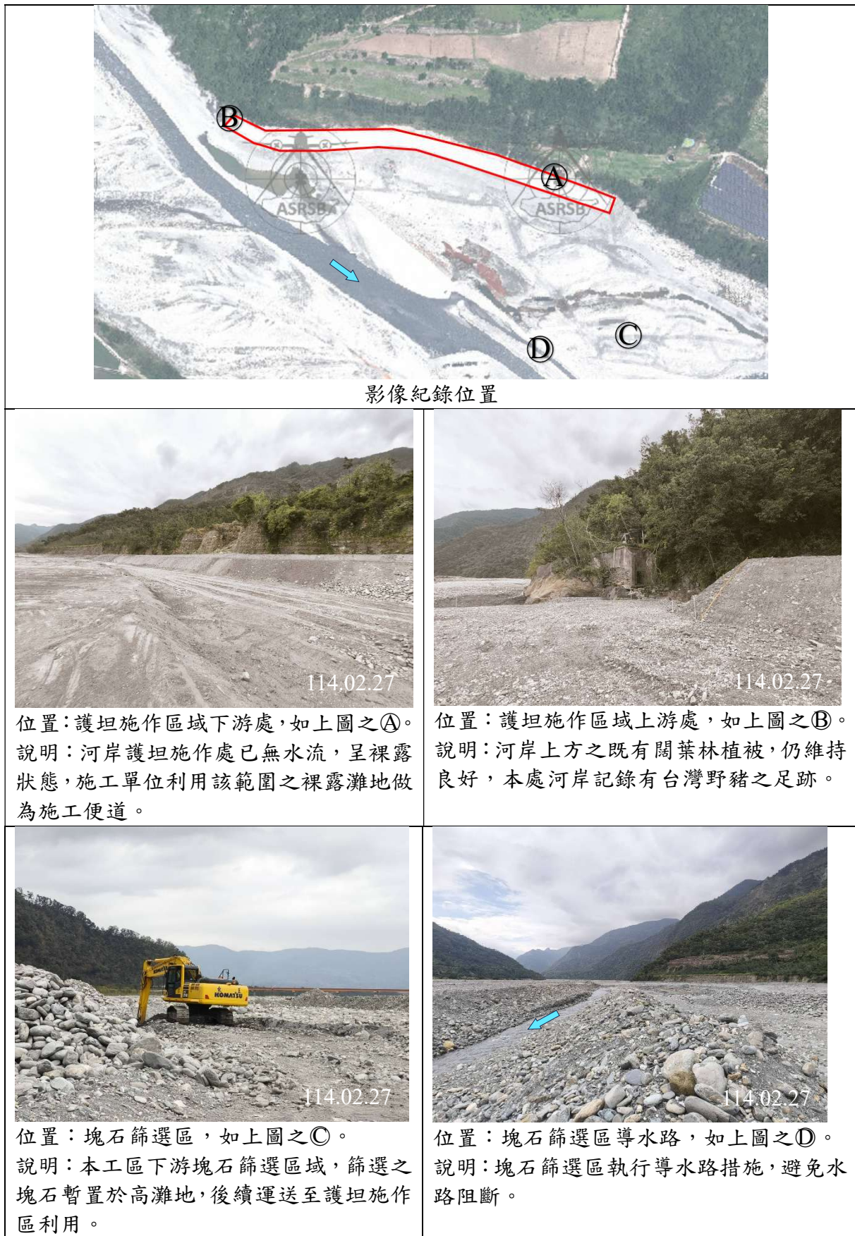
圖 2-5 施工中環境概況紀錄(1)
