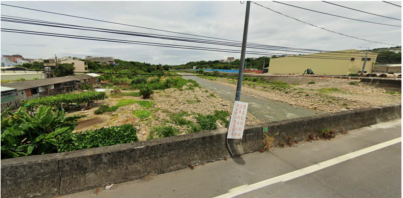
圖 38 溫寮溪上游(攔河堰-水美街)-現況照片
