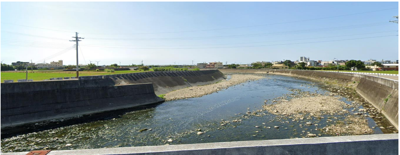
圖 41 溫寮溪中游(經國路-臺 61 線)-現況照片
