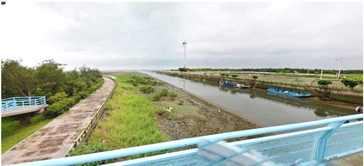
圖 44 溫寮溪下游(臺 61 線-出海口處)-現況照片
