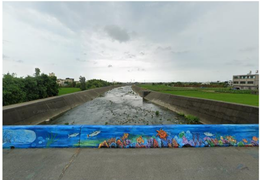
圖 51 溫寮溪下游段松雅橋水質檢測圖
