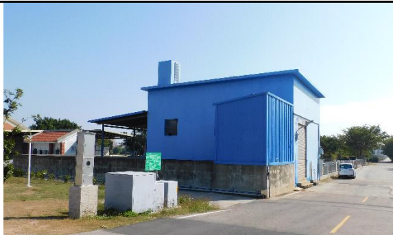
日期：112 年 12 月 26 日 位置：金沙抽水站站體及周邊環境
