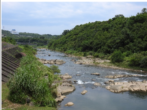
2019/08/12 工程預定位置
