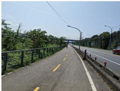
19 自行車道臨於堤外便道側，與車道間設有緣石車阻及反光導標。
