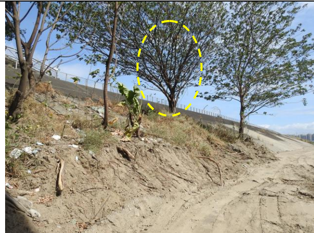
110/10/08 工程起點附近護岸上構樹 (24°58'48.3"N 121°25'47.9"E)
