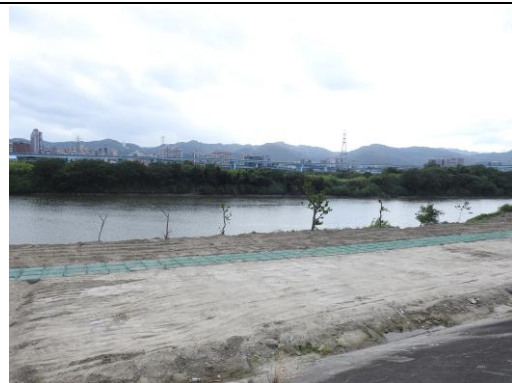
110/10/08 移植區建議保持土壤潮濕
