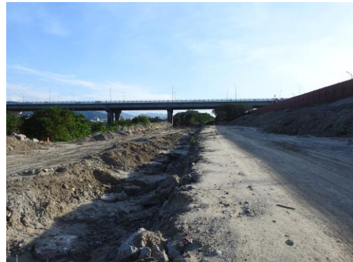
110/06/18 工程施作區域
