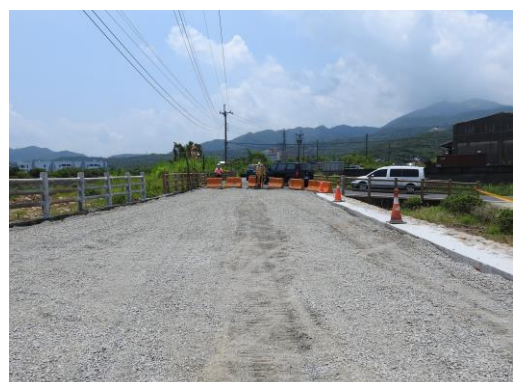
110/07/28 施工中道路封閉
