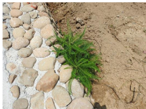
110/07/28 施工中 田菁自然生長
