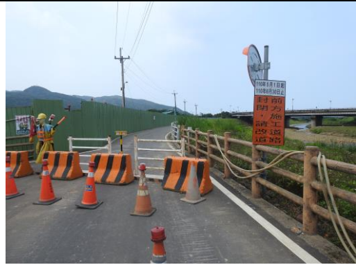
110/05/04 施工中道路封閉
