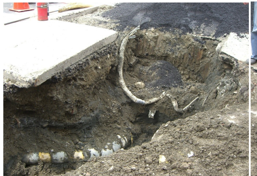
溶穿 PE 瓦斯管之台電公司螺紋電纜管（內有 5 條電線）
