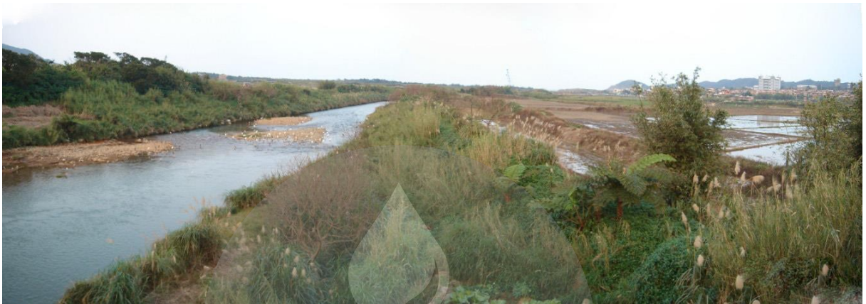
四十號橋下游現況照片
