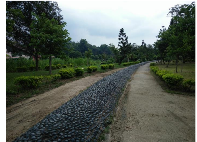
工程設施照片（親水公園步道）
