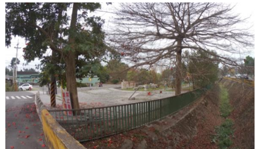
堤後排水路現況
