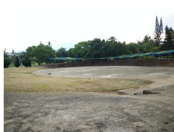
工程設施照片（親水公園廣場）
