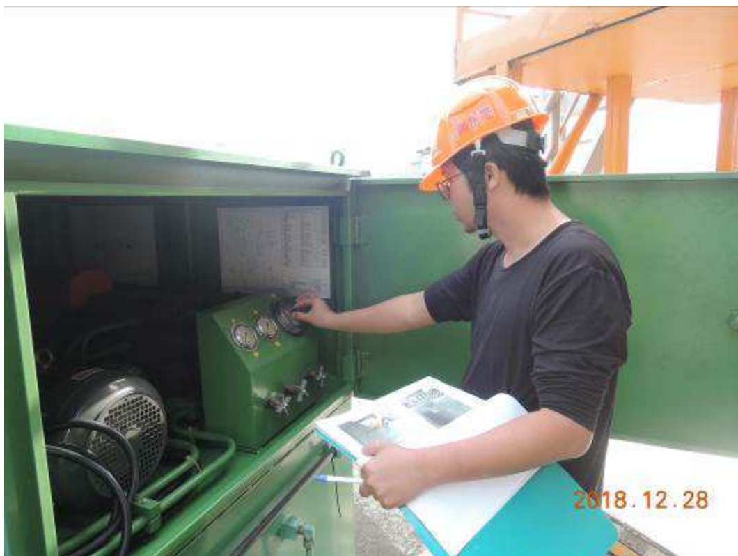
圖 4.3.2：取水口排砂閘門-油壓設備運轉檢查
