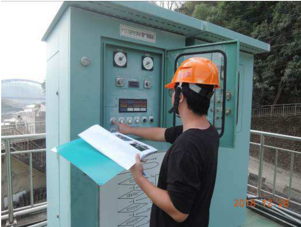
圖 4.4.1：沉砂池排砂閘門-控制箱電源及運轉檢查
