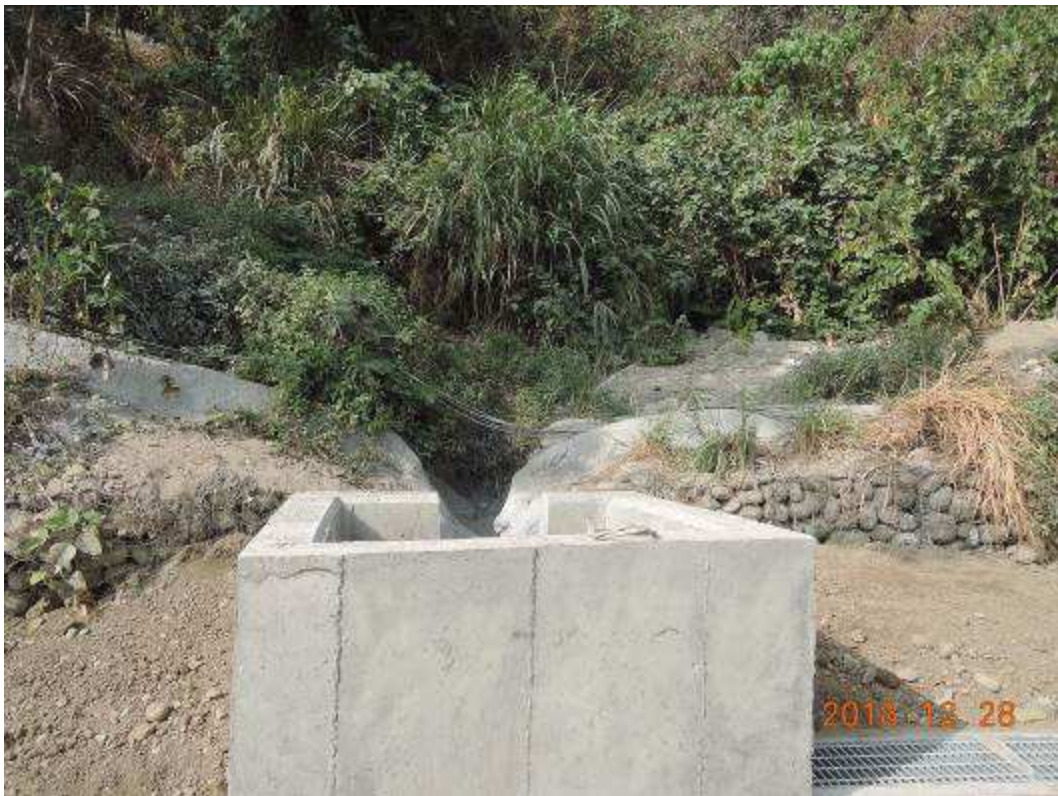
圖 7.2： 三號蝕溝兩側崩塌擠壓導致蝕溝寬度變窄-106 年聯外道路邊坡水土保持工程完成 過路箱涵改善寬度變窄
