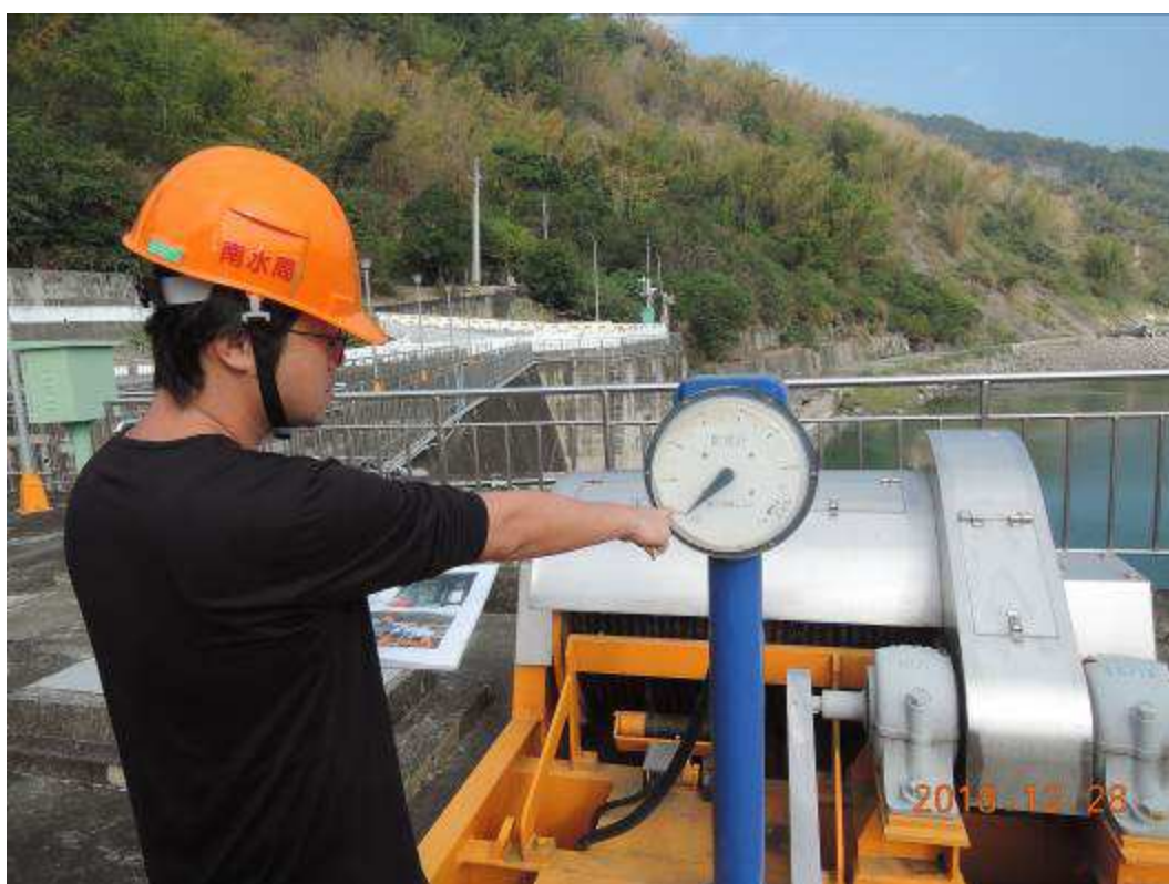
圖 4.1.2：排砂道擋水閘門-外部檢查
