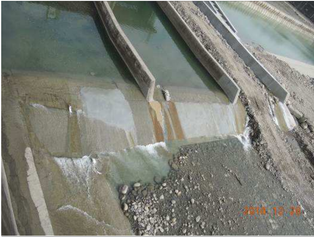
圖 1.2.3 #1 排砂道尾檻磨耗-107 年開口二期完成修復改善
