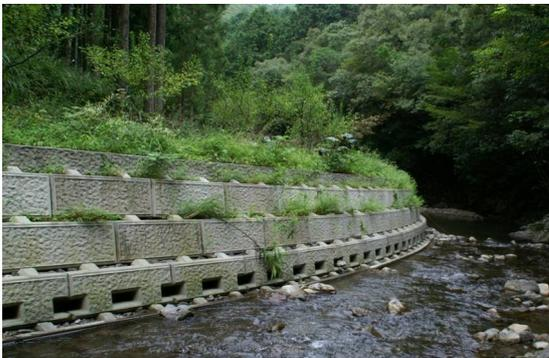
圖 4 預鑄工法護岸示意圖(網路資料)
