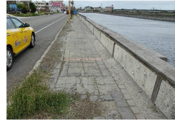
6 鹽館溝旁人行道現況
