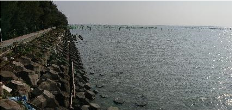
水岸及護坡照片
