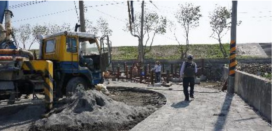
工程設施照片(既有人行設施)
