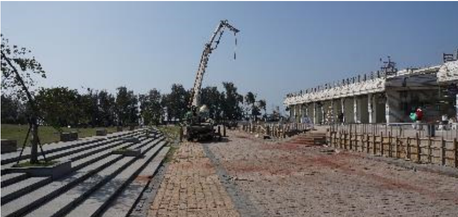
工程設施照片(既有人行設施)
