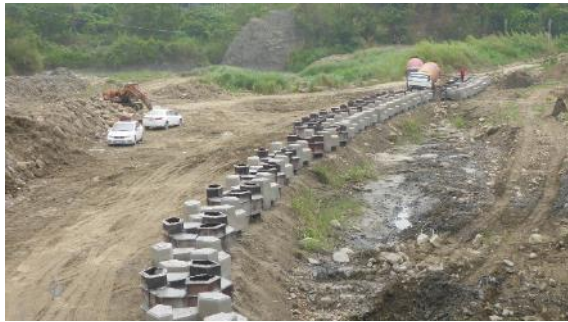
照片 5：利用既有道路進行整地預鑄
