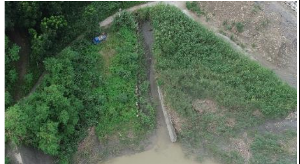
照片 8：支流水路整理後植被回復情形
