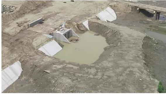
照片 5：一工區水門施工現況
