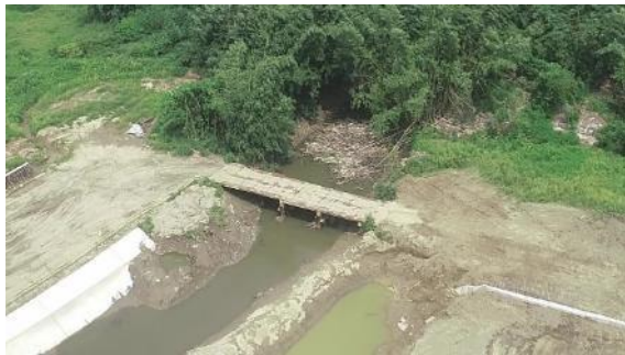
照片 7：一工區使用過水橋減少便道開挖之範圍及減少工程機具進入河道汙染水質
