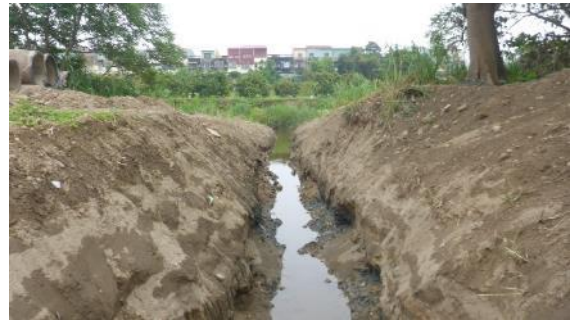
照片 6：施工中維持土溝棲地環境型態
