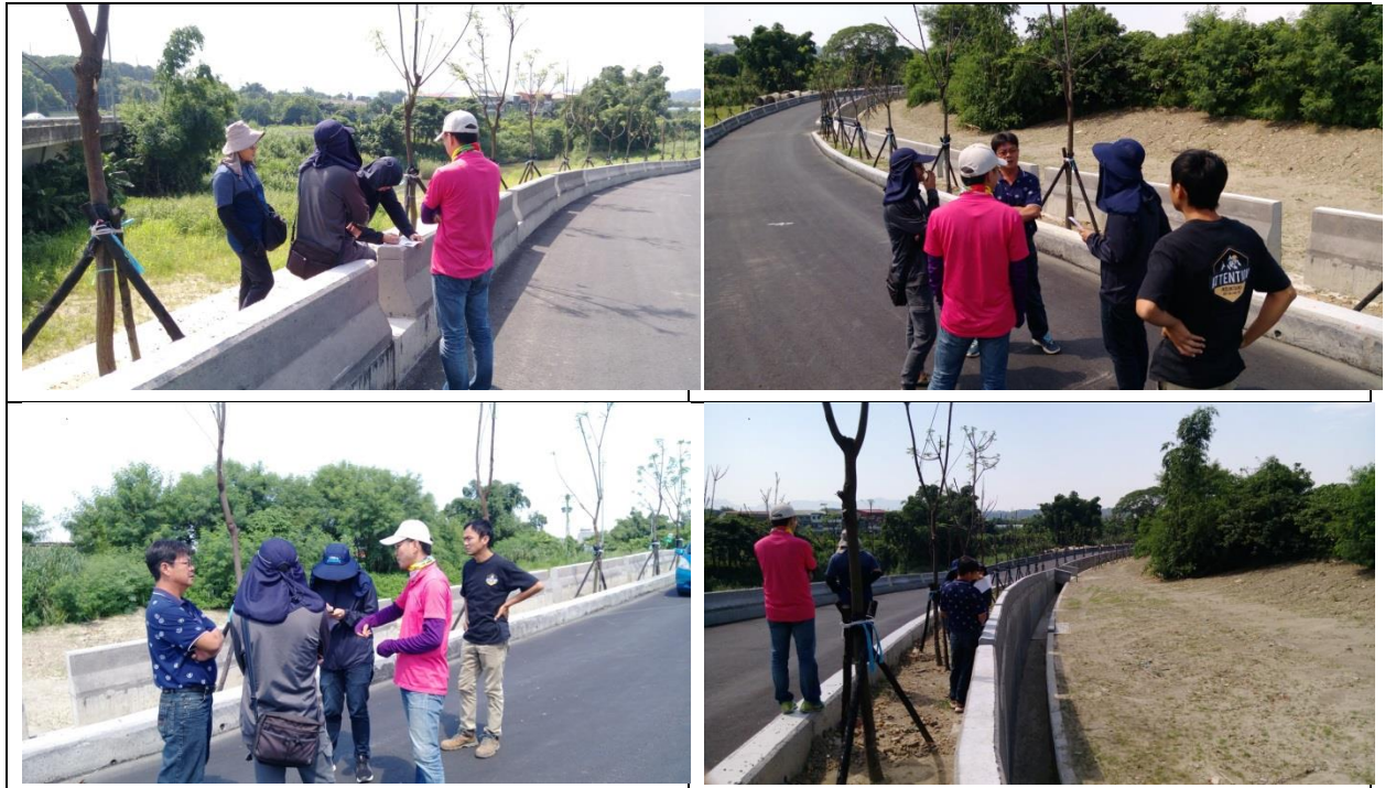
圖 5-1 獅仔頭溪常善護岸防災減災工程施工說明會現況圖
