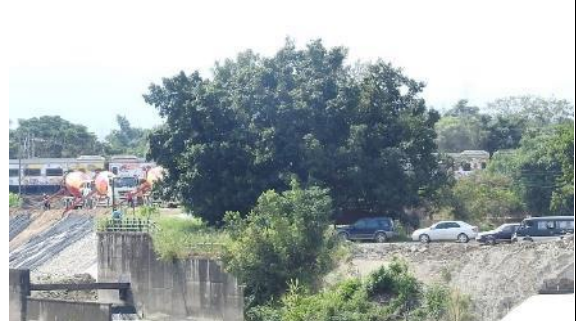
照片 10：二工區左岸榕樹大樹保存現況
