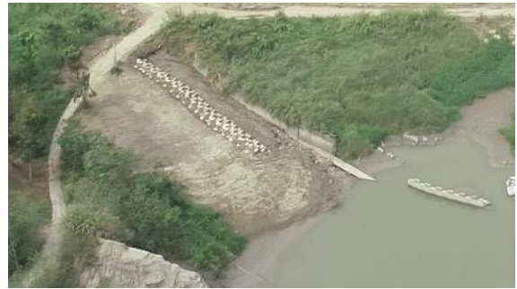
照片 6：支流水路坡腳保護工施工情形
