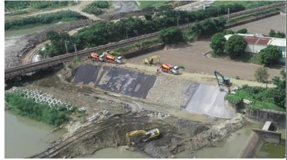
照片 6：二工區護岸施工現況
