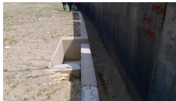
照片 8：施工後側溝生物逃生通道設置
