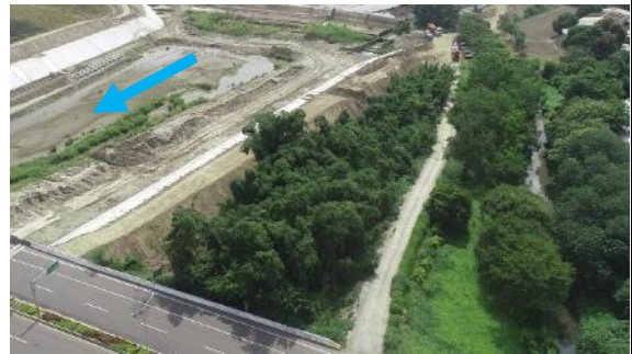
照片 8：二工區利用既有便道及保留左岸濱溪林地
