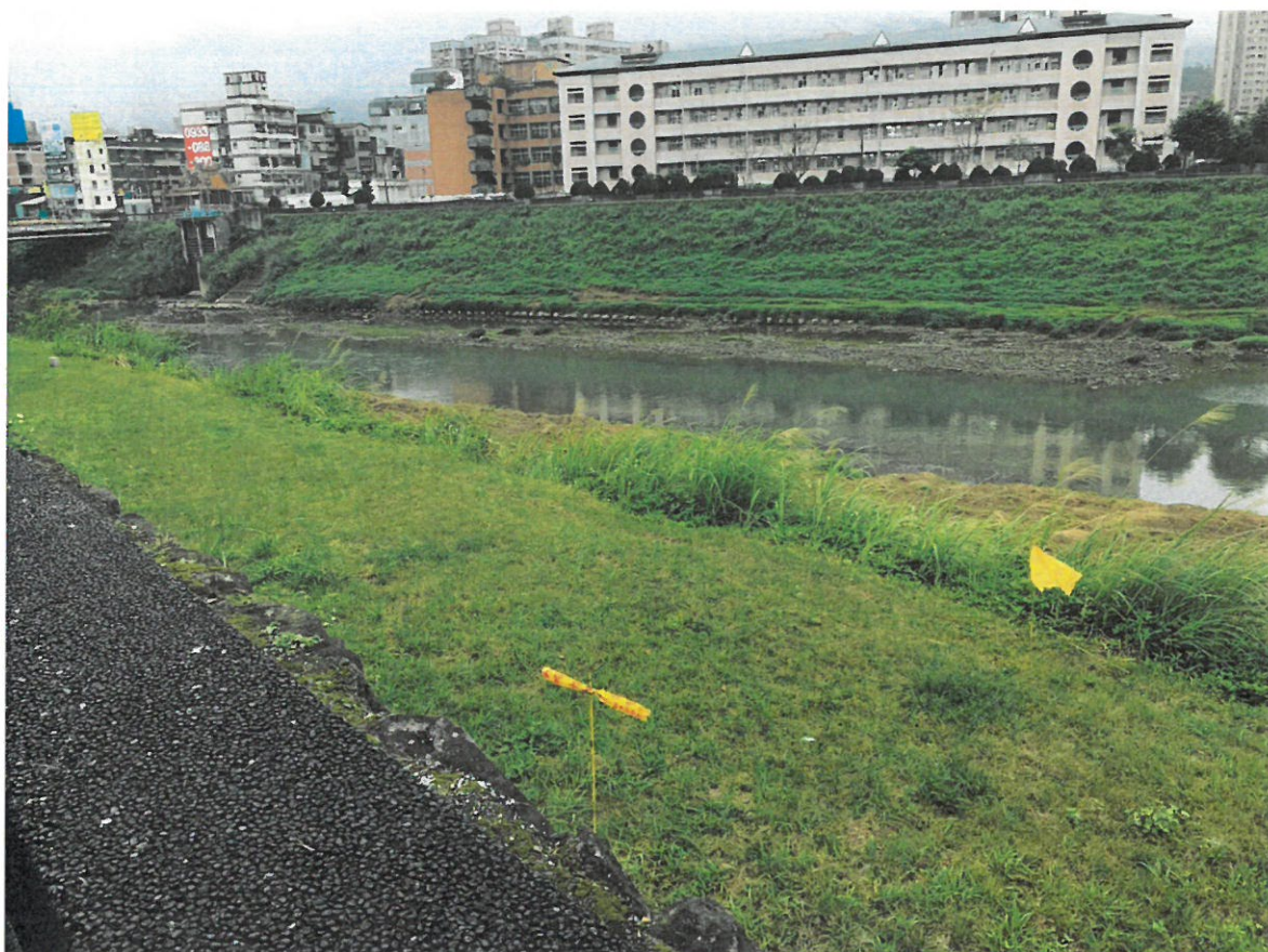
會勘照片：施工範圍位於堤外側最上層石籠(戽台)區域界線
