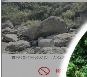
現場生態保育措施 天然塊石保留
