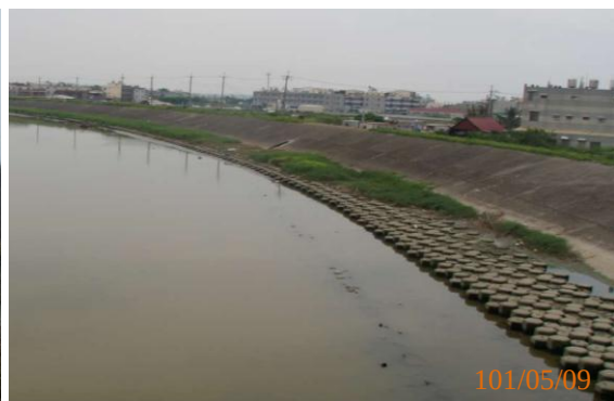
照片 3-2 凹岸處拋置混凝土鼎塊護岸
