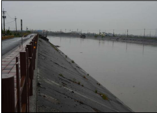
照片 6-26 阿公店溪河口段堤面
