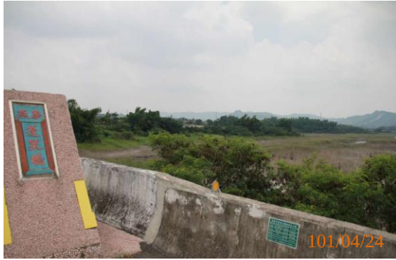
照片 3-23 濁水溪蓬萊橋
