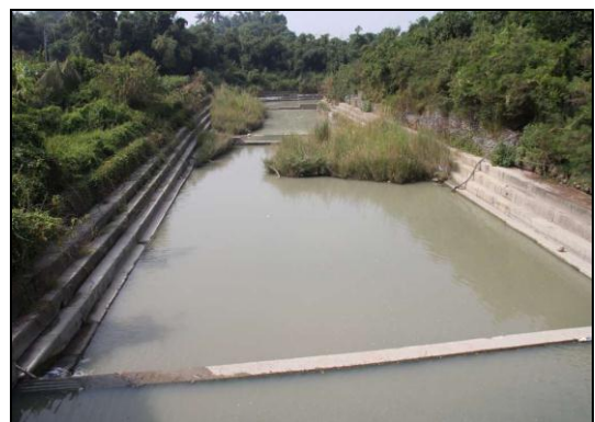
照片 6-29 濁水溪中游混凝土護岸
