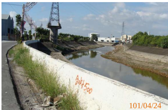
照片 3-13 草溝橋下游(枯水期)
