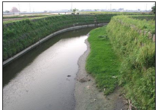
照片 6-35 土石籠施工範例
