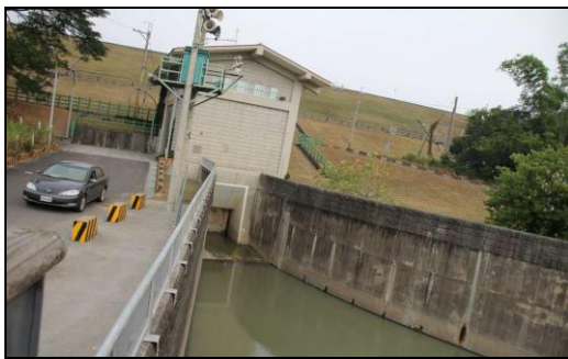
照片 6-7 水庫溢洪道
