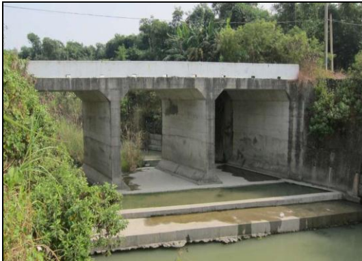
照片 6-21 濁水溪白嶺箱涵固床工
