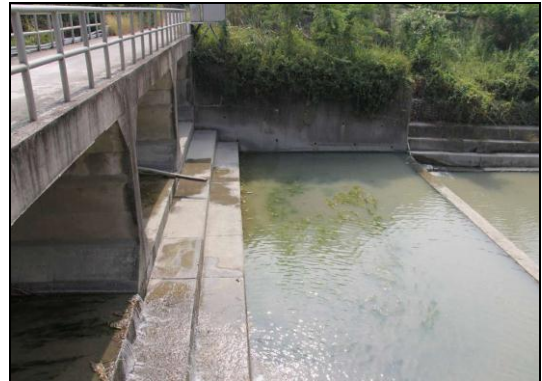
照片 6-22 濁水溪石門仔箱涵固床工
