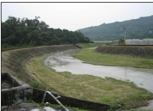
照片 6-28 阿公店溪上游混凝土護岸
