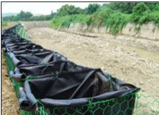
照片 6-34 土石籠施工照片
