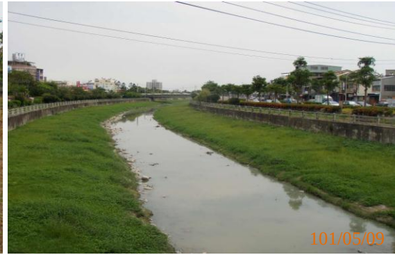
照片 3-4 河槽呈複式斷面
