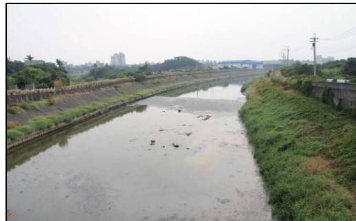
照片 6-10 岡山橋下游
