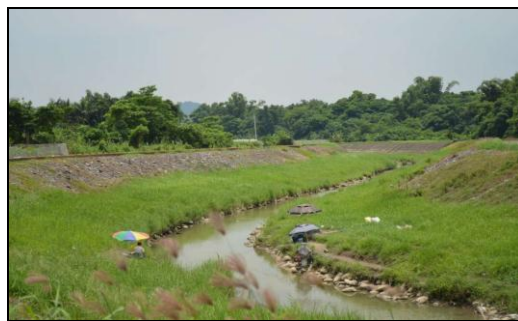
照片 6-8 水庫溢洪道下游
