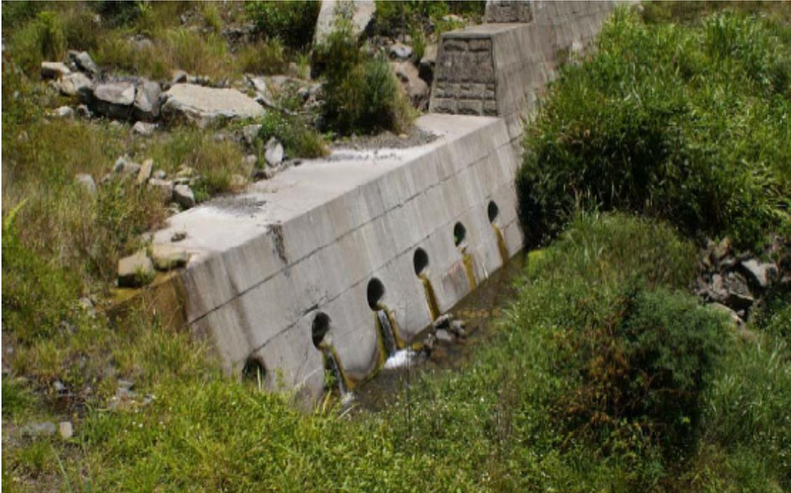
圖 2.3-6 水流被束縮導入混凝土箱涵管流等人工構造物
