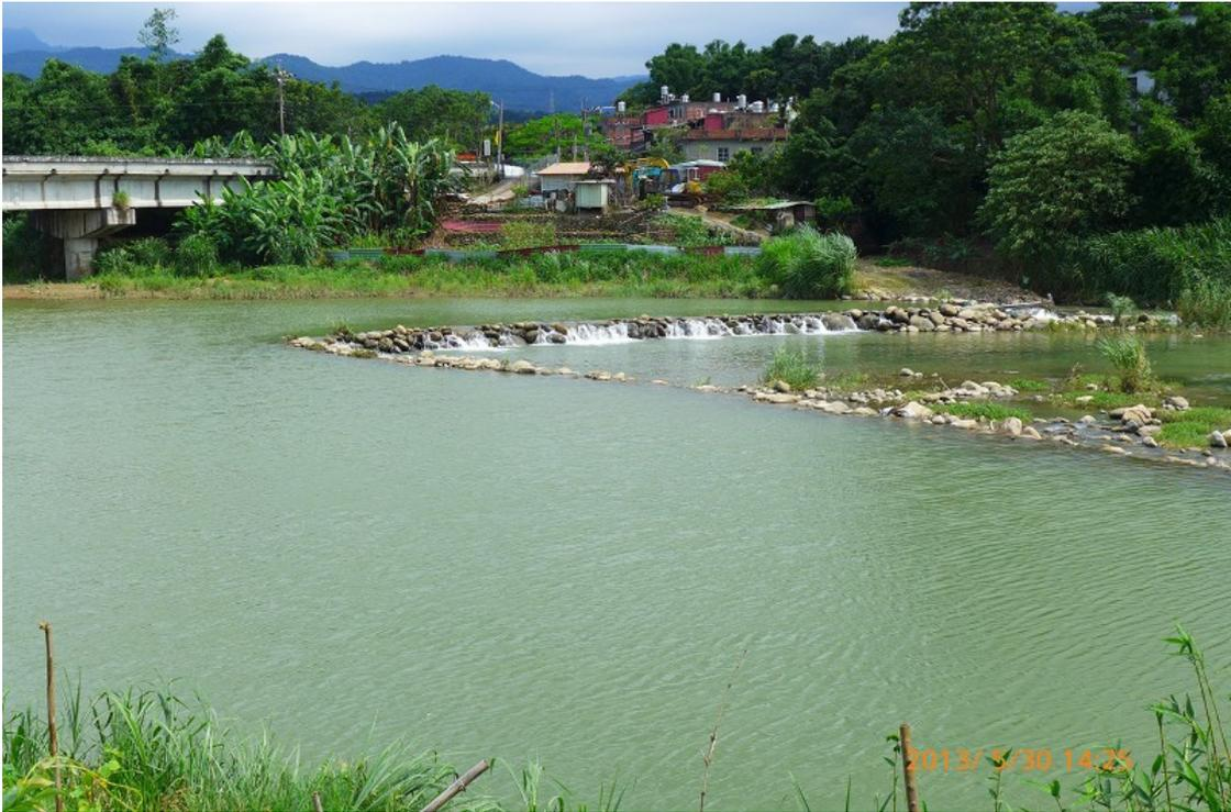
圖 2.3-5 雖有人工構造物，但上下游水流之連續性未遭阻斷
