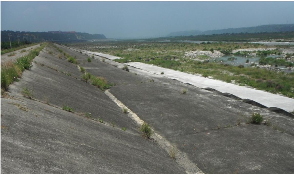
圖 2.3-16 溪濱廊道連續性大部分已遭受人工構造物(混凝土)阻斷
