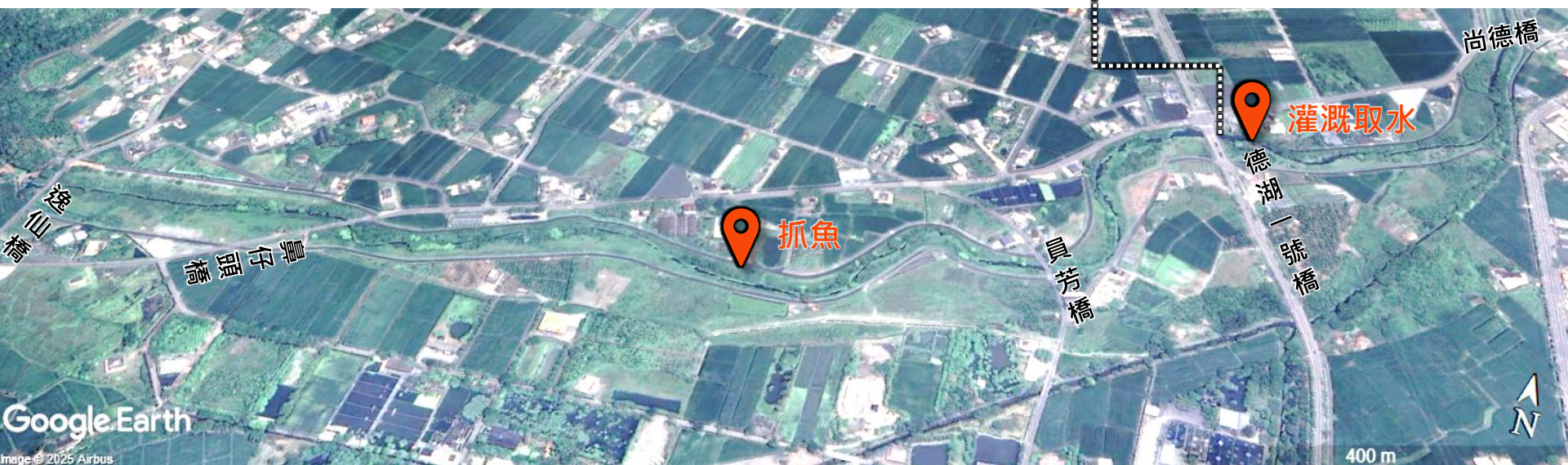
攔水堰取水灌溉周邊農田
