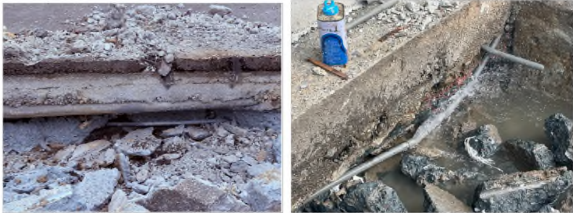
牽引道B落墩處開挖後之管線照片（上二圖）
