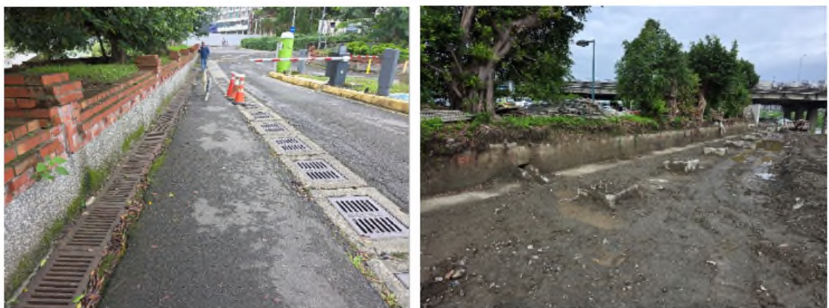
現場開挖後之暗溝、陰井及周邊排水系統照片（上二圖）
