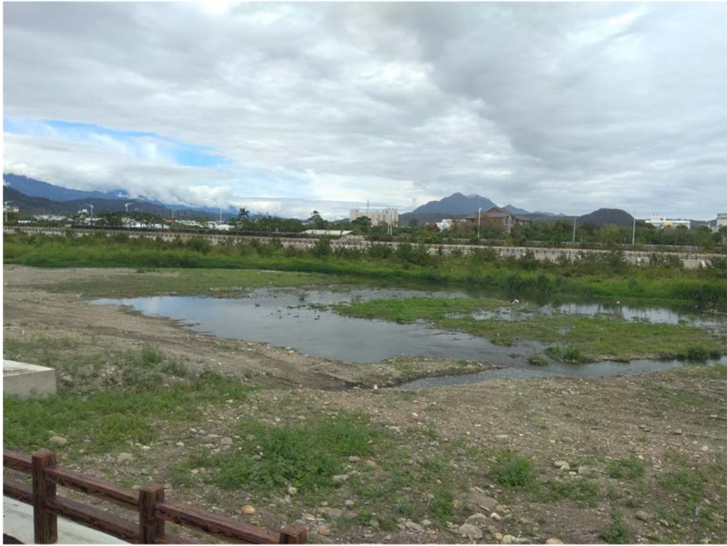
說明：卑右三生態池連通太平溪箱涵排水狀況
