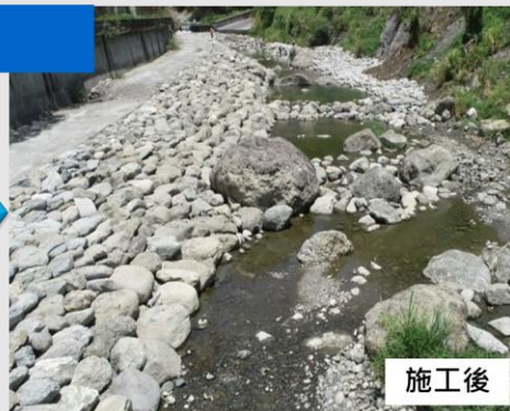
河岸粗糙化-改善平滑護岸
