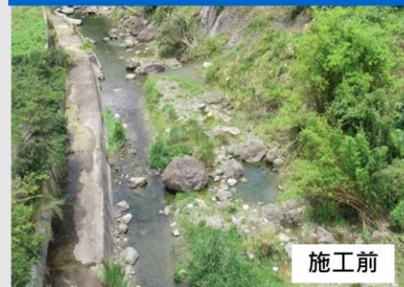
河岸粗糙化-改善平滑護岸
