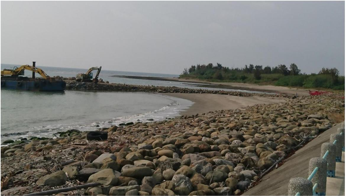
已核定分項案件-突堤近岸淤沙情形 01(2021 年 03 月)
