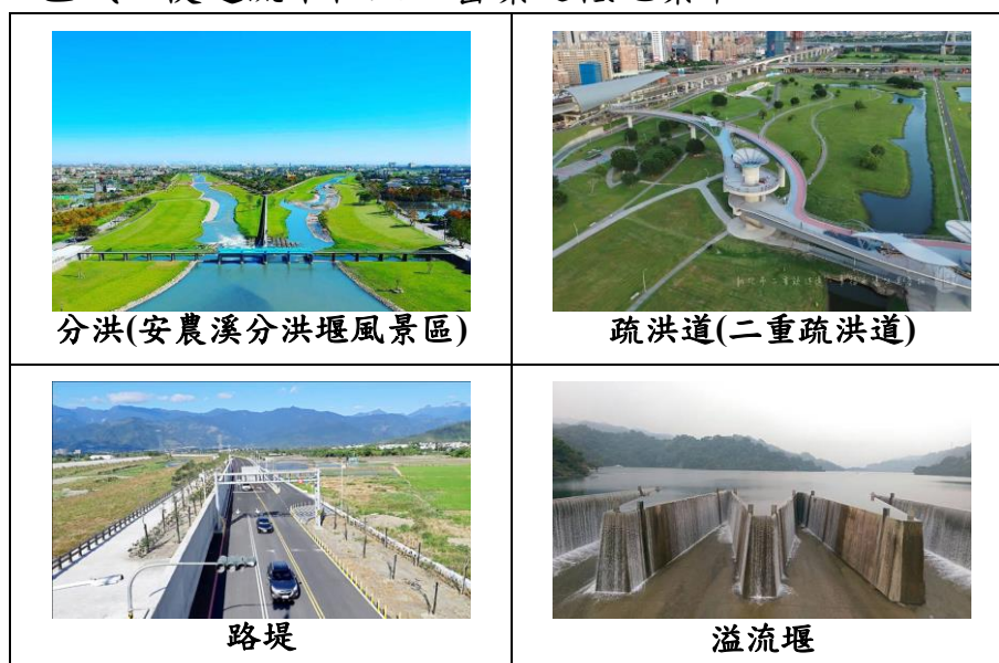
圖 5-4 逕流分散措施示意圖
