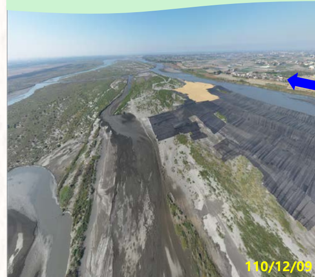
第二區 大義崙下游40-44號越堤
