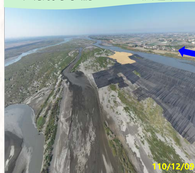
第二區 大義崙下游40-44號越堤
