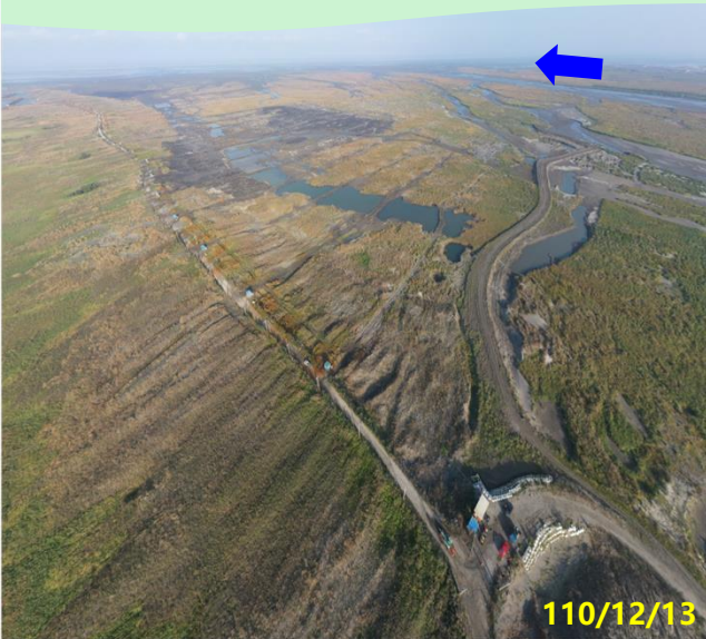
第一區 麥寮出海口200公頃
