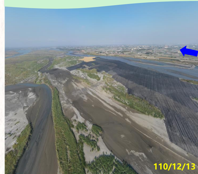
第二區 大義崙下游40-44號越堤
