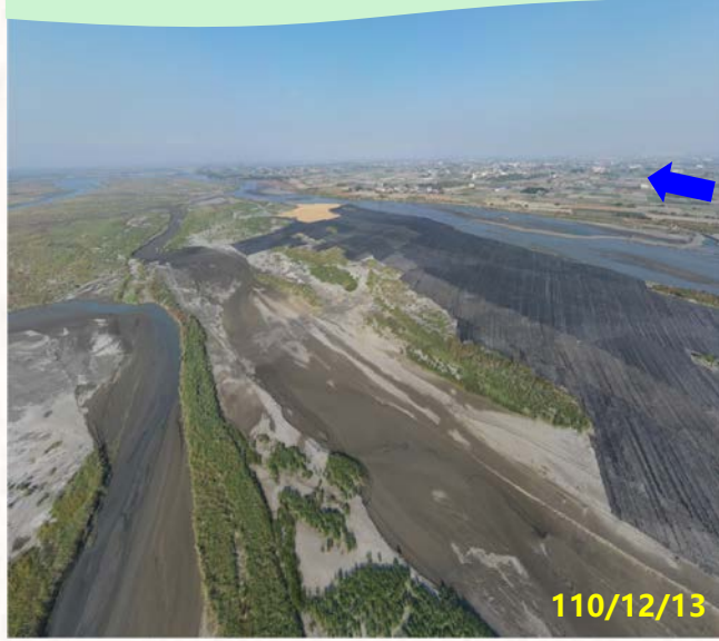
第二區 大義崙下游40-44號越堤
