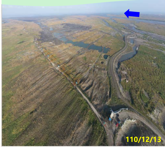
第一區 麥寮出海口200公頃
