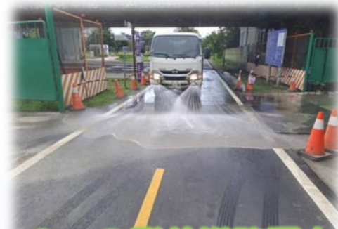
Step3.聯外道路灑水 抑制揚塵
